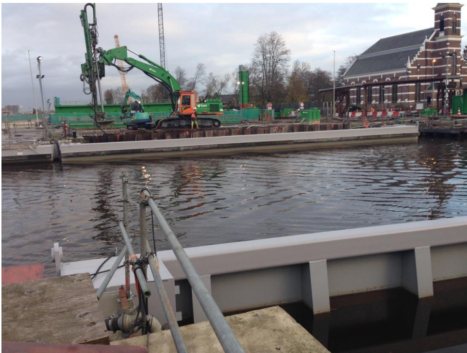
De Oude Rijn stroomt door de stalen bak, aan de overzijde is de stalen Compartimenteringswand nog te zien.
