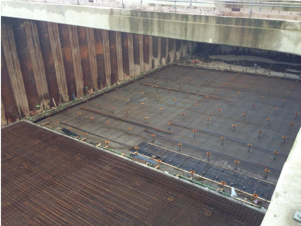
Verdiepte ligging bak A4, te zijn verschillende bouwfases
