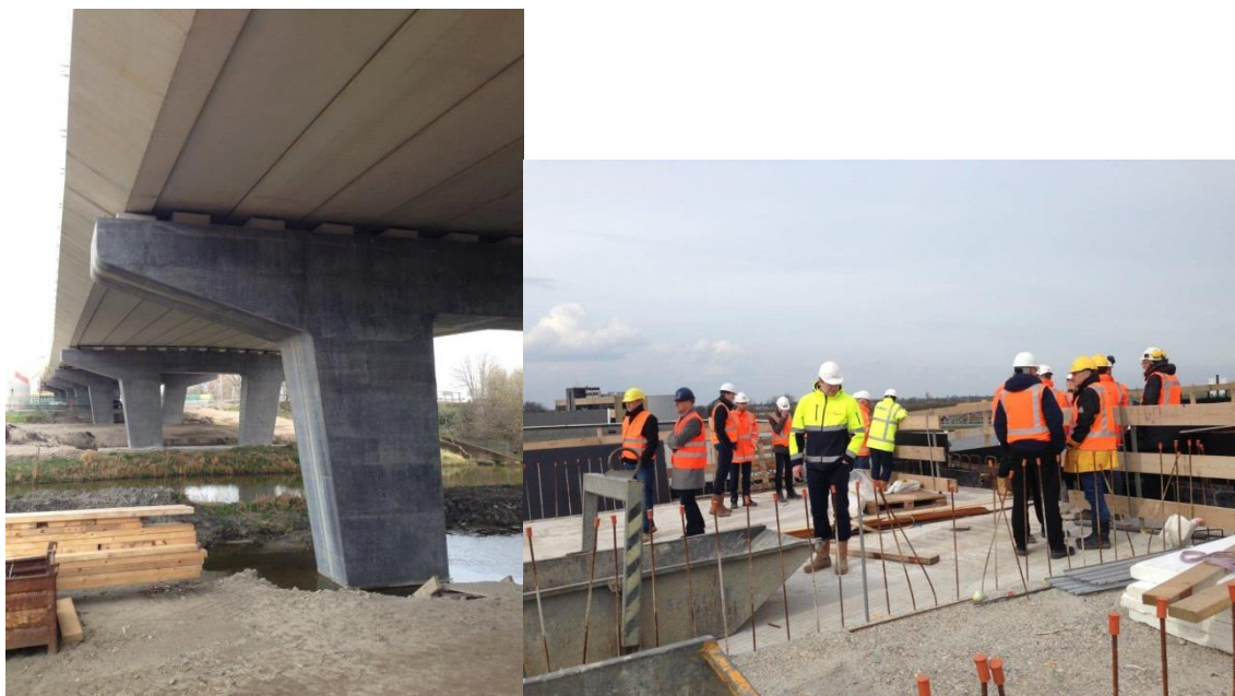
Foto's Gouwekruising onderzijde en bovenzijde in aanbouw
