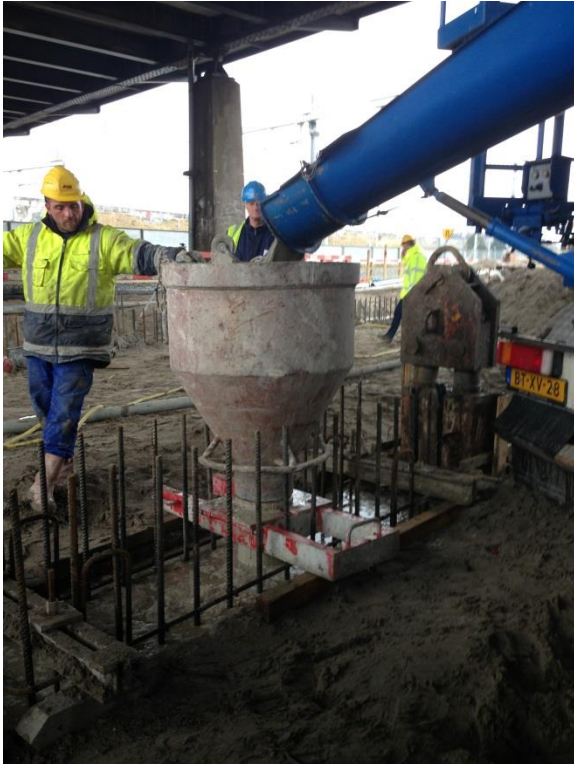
Storten van beton tussen prefab betonnen dilatatiebalken bij dive-under
