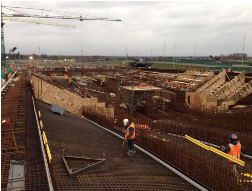
Bovenzijde Verlengde Waalbrug
