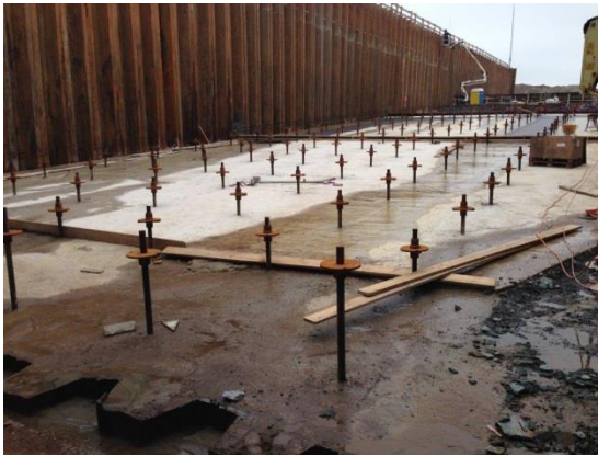
Ankers tegen opdrijven aquaduct onder Prinses Margrietkanaal
