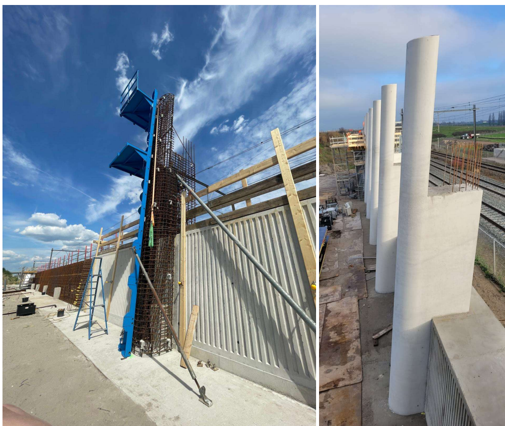
Figuur 26 Kolommen pergola tijdens en na uitvoering
