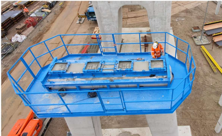
Figuur 19 Opstortbekisting met gekoppeld bordes
