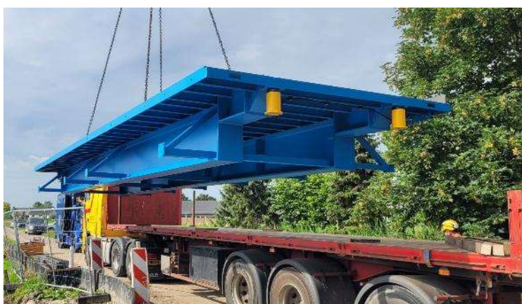
Figuur 21 Dekbekisting (met vijzels aan de uiteinden) voor de realisatie van de dekken van de aanbruggen
