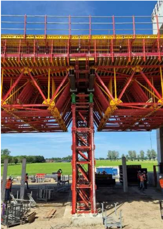
Figuur 15 Vakwerkliggers van het ALPHAKIT-systeem zijn opgelegd op een toren van het VST-systeem
