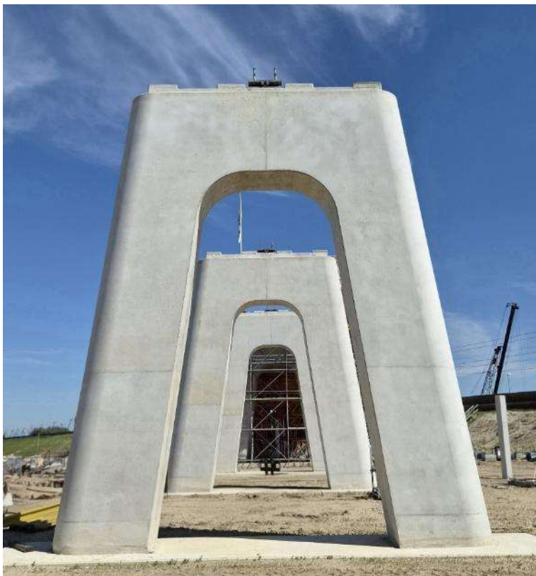
Figuur 13 Voor het beton strenge eisen aan de oppervlaktekwaliteit
