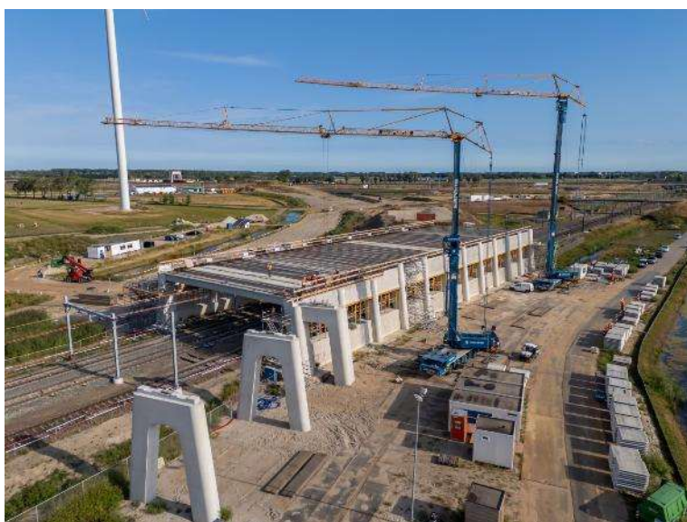
Figuur 11 Bouw pergola over de bestaande spoorlijn Utrecht – 's-Hertogenbosch (KW16)
