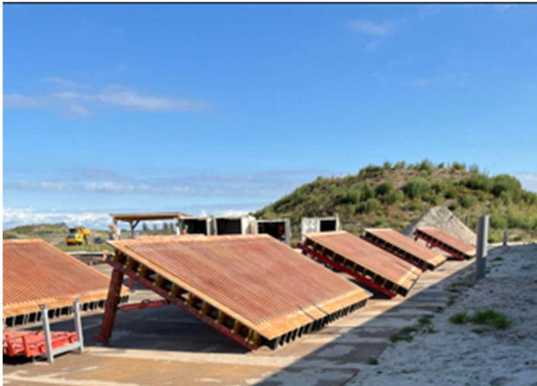
Figuur 23 Bekisting voor de pergolawanden met houten elementen voor de profilering
