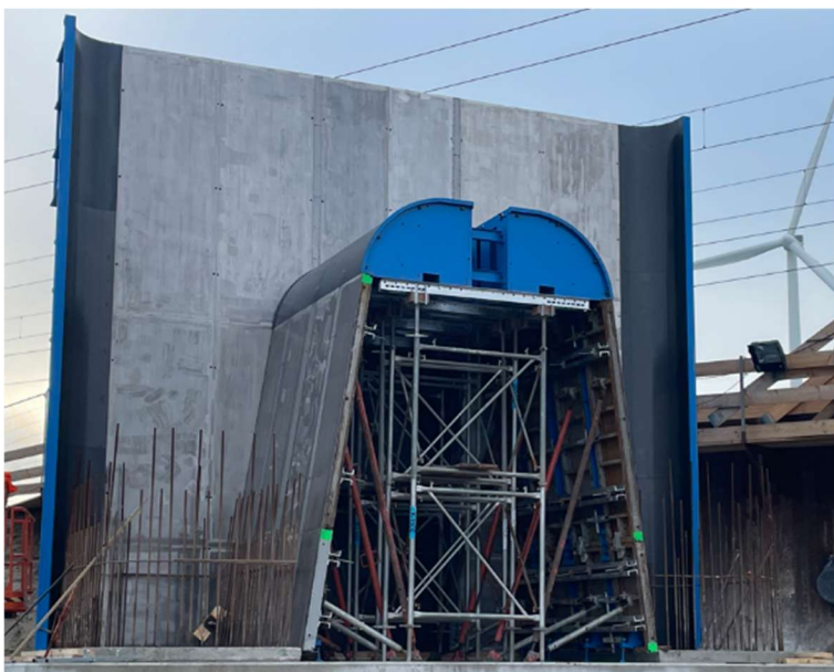
Figuur 20 Combinatiebekisting voor de trogpijlers (systeembekisting met stalen bekisting)
