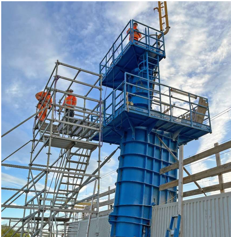
2 Stalen bekisting voor een van de pijlers van de pergolaconstructie
