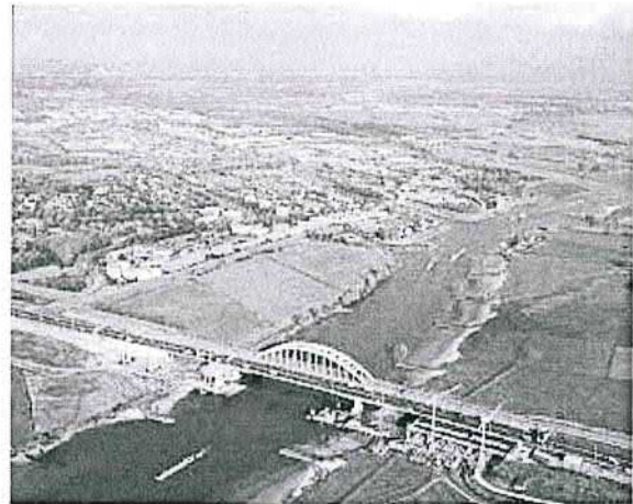
Figuur 4 - Derde Lekbrug Vianen in aanbouw
