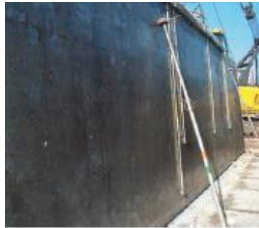
Bekisting ingeneveld met emulsie die bijna is opgedroogd
