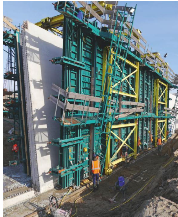
Foto 2.4 Stalen bekisting, toegepast bij project Ruimte voor de Waal. Foto: Hendriks precon
