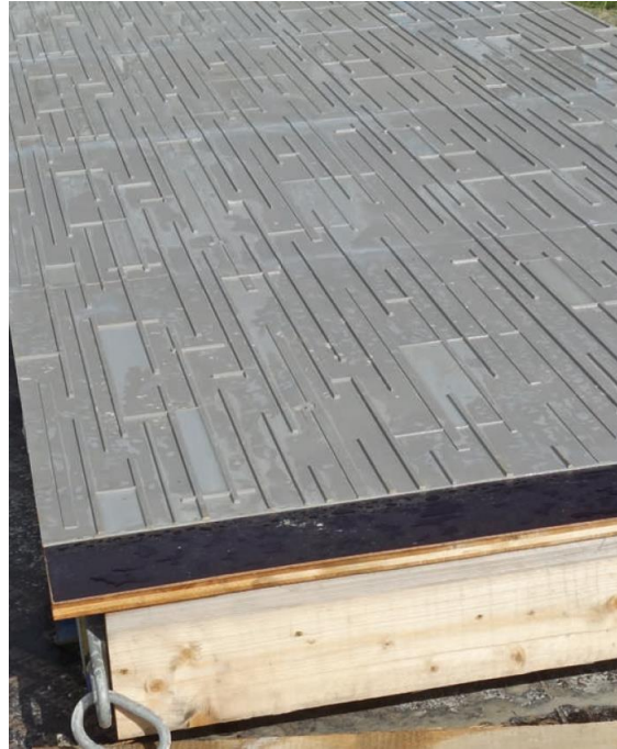
Foto 1.5 Kunststof profielmat als contactbekisting
