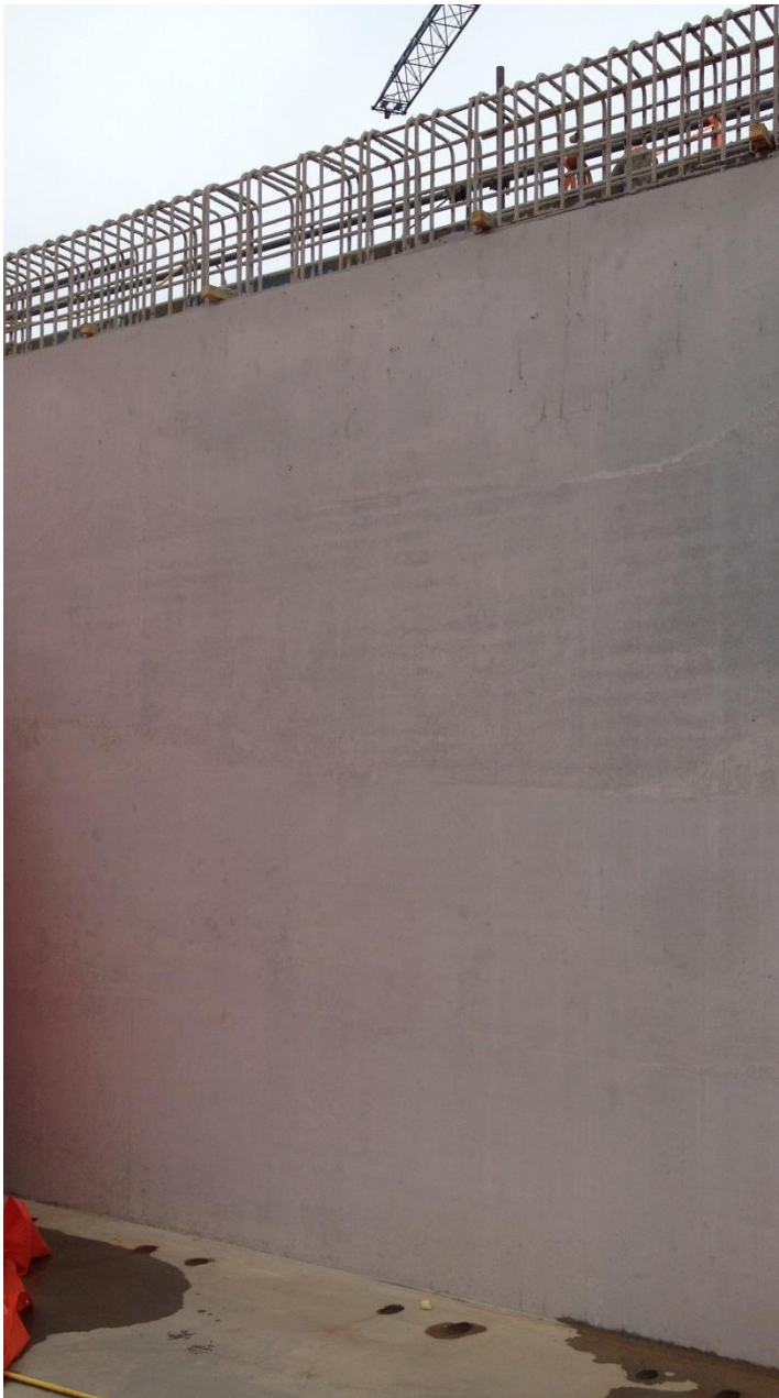
Foto 1.15 Wand uitgevoerd met bekisting zonder centeringen Foto: Doka
