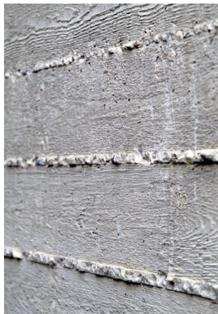
Foto 1.3 Houtstructuur in het beton, ontstaan door gebruik van houten contactbekisting foto: Cement&BetonCentrum
