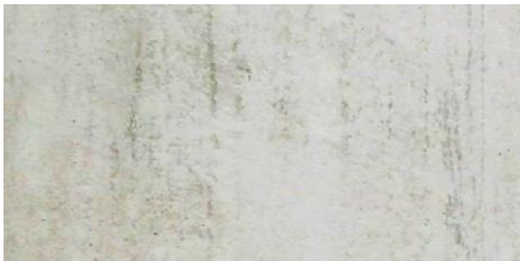
Foto 4.2: Strepen bij een teveel aan ontkistingsmiddel
