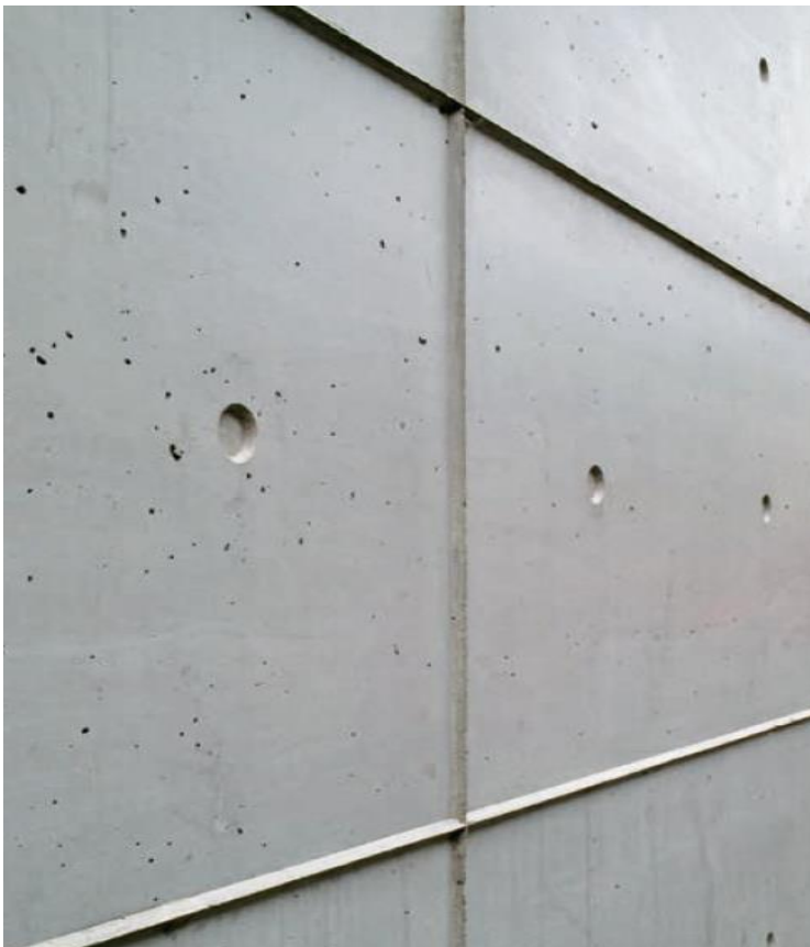
Foto 1.7 Plaat- en elementnaden zijn heel bepalend voor het uiterlijk van beton foto: Cement&BetonCentrum
