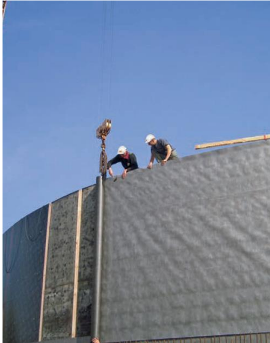
Foto 1.4 Aanbrengen vochtabsorberende Zemdrain-Bekistingsfolie foto: Max Frank Nederland
