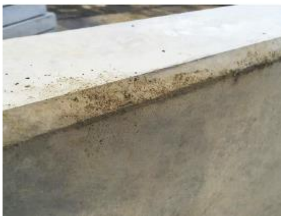
Bij het juiste type en de correcte verwerking van het ontkistingsmiddel ontstaan geen luchtbellen en blijft het beton egaal van kleur.
