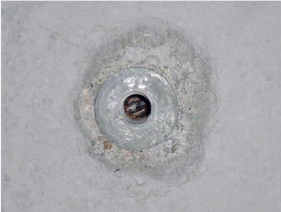
Foto 1.13 'Bleeding': er is bij de centerpensparing een lekweg ontstaan van water uit de betonmortel
