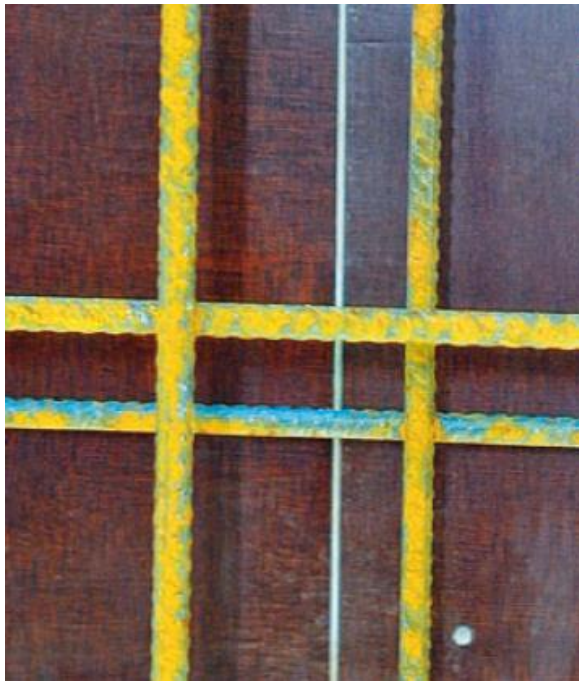
Foto 1.8 Plaatnaden afgedicht met tochtband foto: Doka
