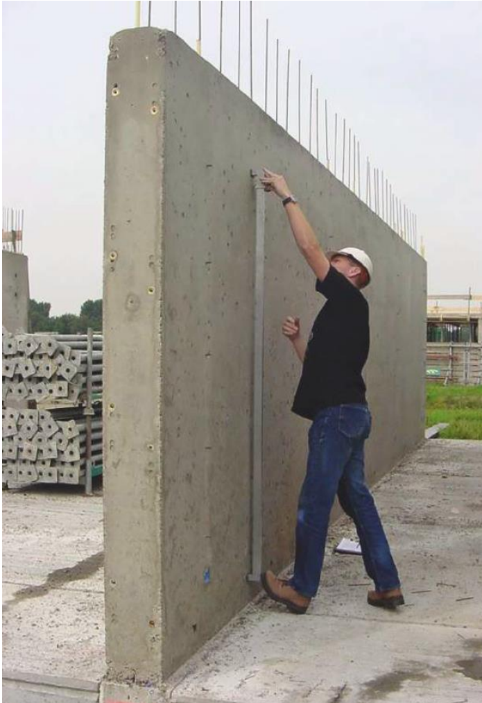
Foto 2.7 Controle betonoppervlak na ontkisten
