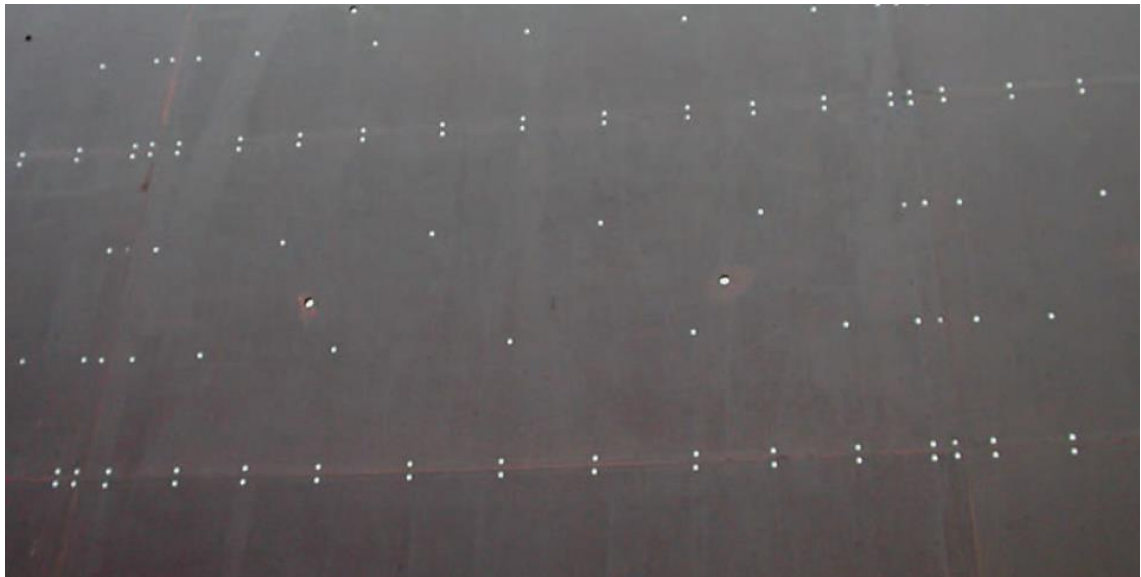
Foto 1.10 Voorbeeld van een plaatbevestiging in patroon
