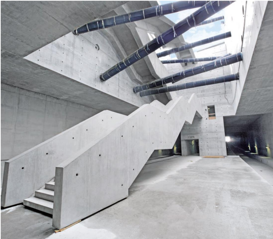
Foto 1.1 Citytunnel in Leipzig, uitgevoerd in schoonbeton
