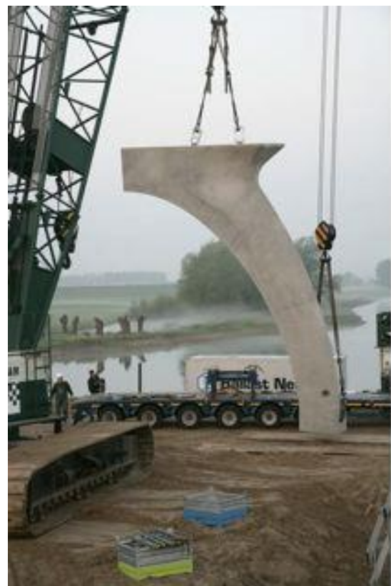
Figuur 122 - Naar de damwandkuip
