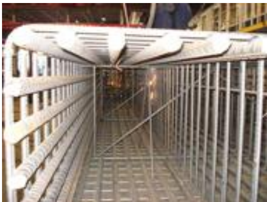
Figuur 64 - De basiskorf met 54 staven \varnothing 40
