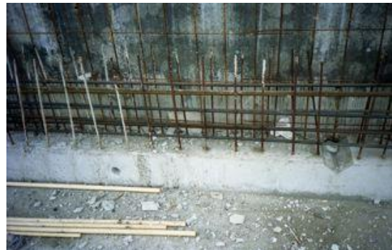
Figuur 56 Eerste voorraadnet geplaatst
