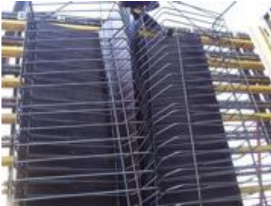
Figuur 72 - De dubbele korf is geplaatst tegen het stelschot. De korven gaan al uit elkaar lopen.
