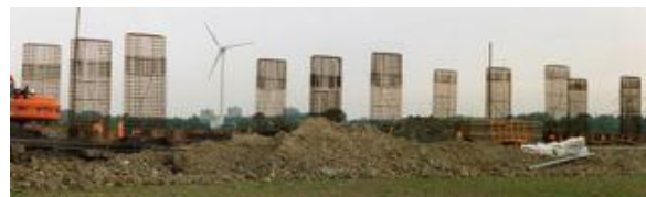
Figuur 106 - Prefab kolomkorven wachtend op bekisting
