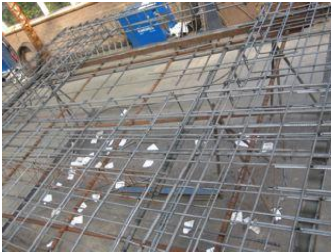
Figuur 59 - Dubbel pasnet met raamsparing voor woningbouw wanden
