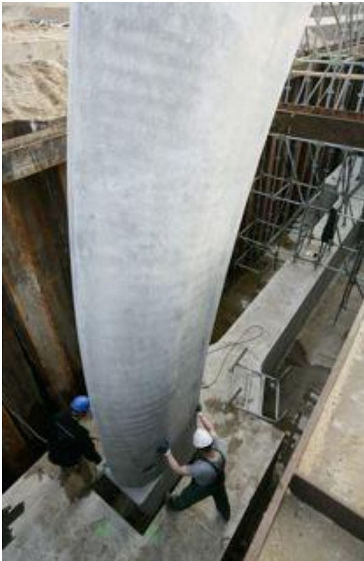
Figuur 124 - Plaatsen in voorgespannen sloof
