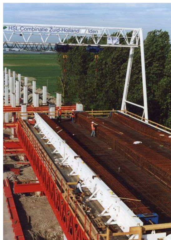
Figuur 107 - De wapening is bijna gereed voor het plaatsen van de bovenbekisting
