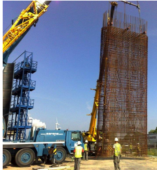
Figuur 151 - De korf zakt over de stekeinden
