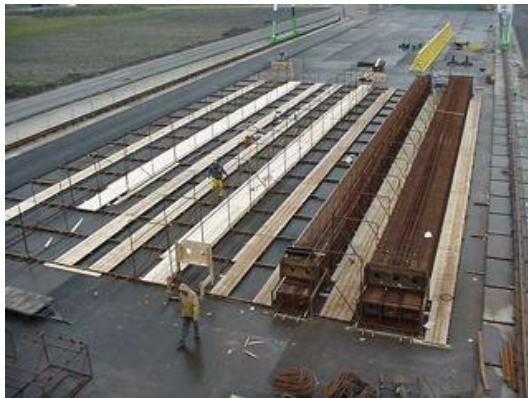
Figuur 108 - De balkkorven worden naast het viaduct geprefabriceerd
