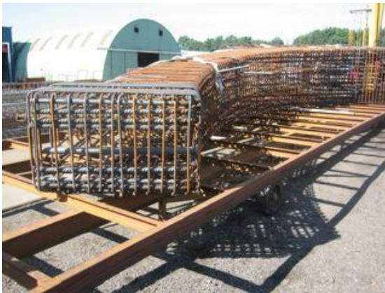
Figuur 118 - De wapeningskorf van een halve pijler ligt in de centrale gereed om te worden vervoerd naar de betonfabriek
