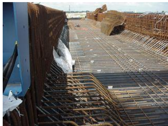
Figuur 113 - Ook op de vloer tussen de balkkorven de nodige prefabricage
