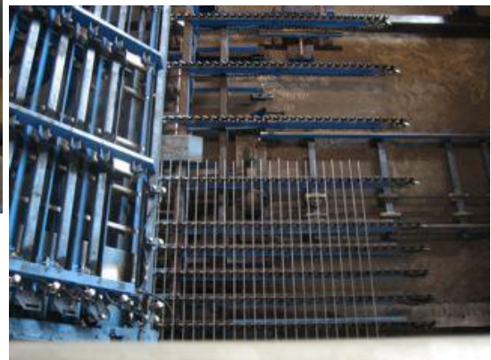
Figuur 27 - Het met ladderbanen uitleggen van de staven
