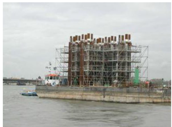
Figuur 179 - Het vervoer van de vijf paalkorven naar de bouwlocatie
