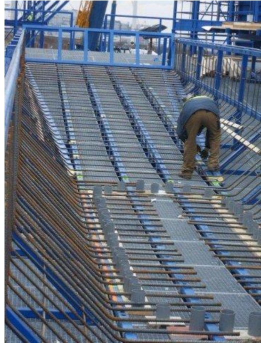
Figuur 159 - Ook heeft de aannemer een hijsbalk laten maken met meerdere takels die handmatig kunnen worden bediend
