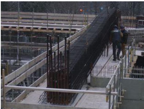
Figuur 77 - De aangevoerde balk wordt in het werk gehesen
