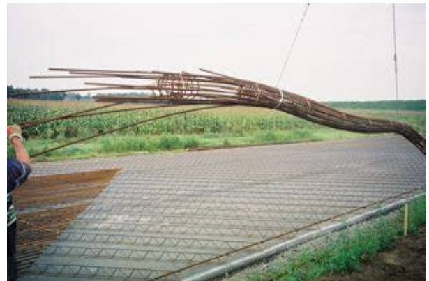
Figuur 129 - De aanvoer van de ruitvormige rolmatten
