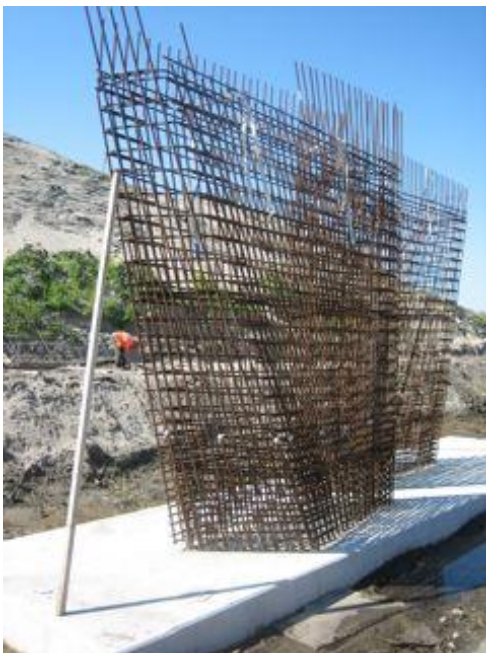
Figuur 132 - Direct na het storten wordt de betonspecie vlak afgewerkt. De stekken steken boven de beton uit.
