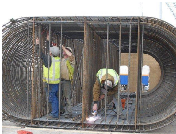
Figuur 147 - De vlechters hebben er lol in om op deze eenvoudige wijze een pijlerkolom korf te vlechten.
