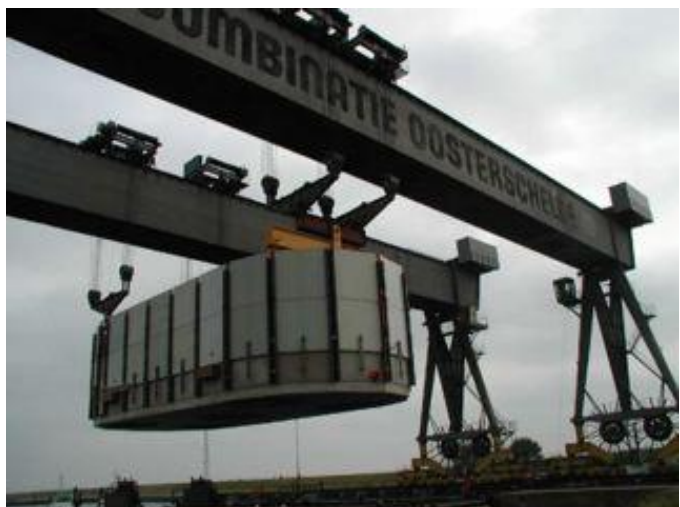
Figuur 175 - De pijlervoet als tijdelijke betonnen bak wordt op een schip geladen
