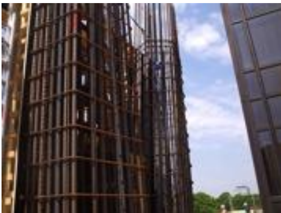
Figuur 74 - Totaal 38 staven Ø 40 moeten de vlechters in de prefab korf laten zakken en in de mechanische koppelingen vastdraaien
