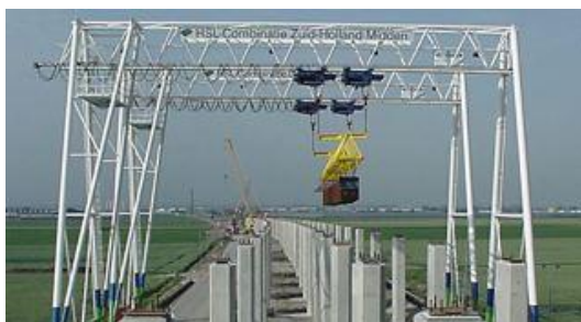
Figuur 112 - Een 35 meter lange balk onderweg naar de bekisting
