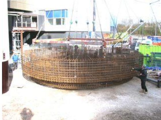
Figuur 83 - De korf is gereed om aangepikt te worden
