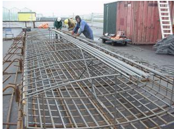
Figuur 104 - Het prefabriceren van de kolomkorven op de bouwplaats in eenvoudige mallen
