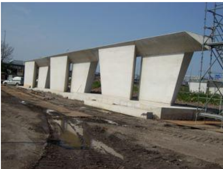
Figuur 137 - De ondersteuning is gereed voor het opleggen van de prefab balken over de pijlers. De automobilist op de A2 zal deze fraaie pijlers niet kunnen zien
