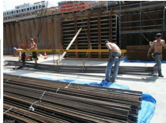
Figuur 91 - Met evenaar aan tweesprong rolmat optrekken
