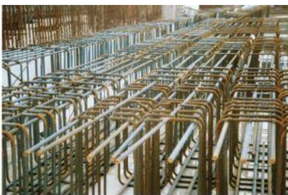
Figuur 141- Geprefabriceerde balken met dwarskrachtbeugels in opslag
