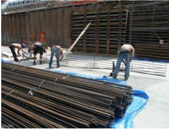
Figuur 93 - Rolmat ophijzen en achter steiger laten zakken
