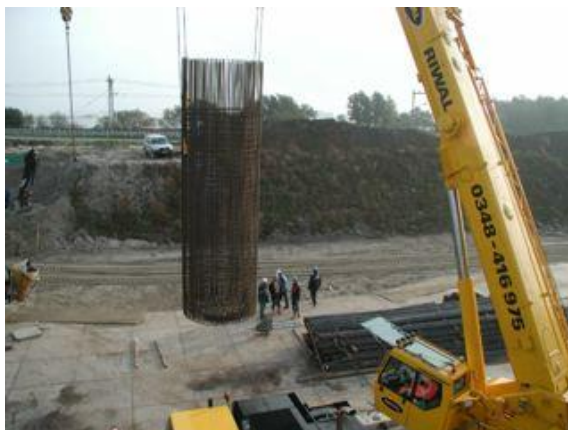
Figuur 178 - Het overeind zetten van de lange geprefabriceerde wapeningskorf Ø 3.000 mm.
