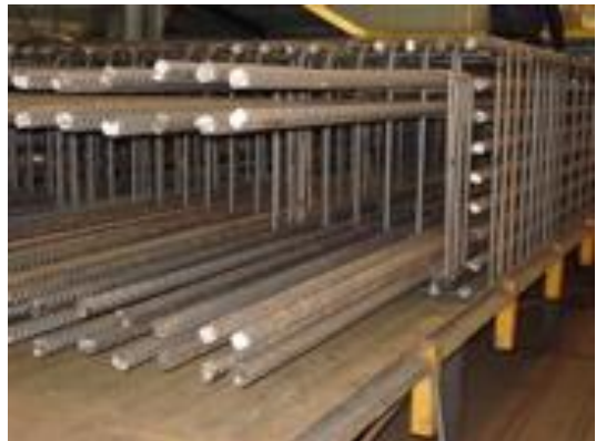
Figuur 66 - Korf met drie lagen hoofdwapening aan elke zijde
