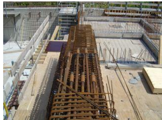
Figuur 78 - Ook na plaatsing moet er nog veel wapening aan worden toegevoegd. De mechanische koppelingen laten dat zien.
