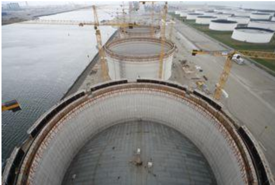
Figuur 189 – Bij de bouw van de drie tanks van de LNG terminal op de Maasvlakte met een diameter van 86 m en 50 m hoog zijn veel gebogen wandnetten plat op de grond geprefabriceerd.
