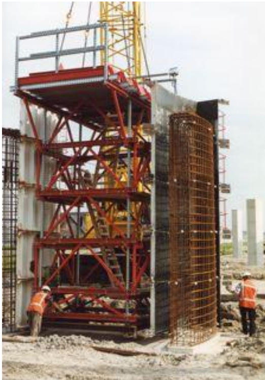
Figuur 105 - Tussen de prefab kolomkorven wordt de speciale kolombekisting geplaatst
