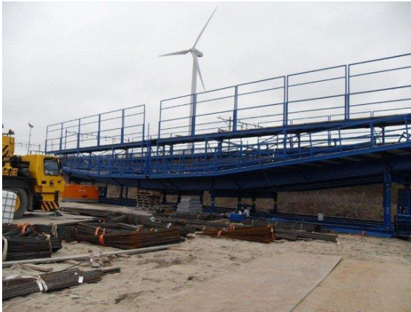
Figuur 158 - De vlechter is begonnen met de eerste laag wapening. Voor de korf heeft hij een volle week de tijd binnen de weekcyclus van de pijlerbouw. Zonder prefabricage was een weekcyclus niet mogelijk geweest
