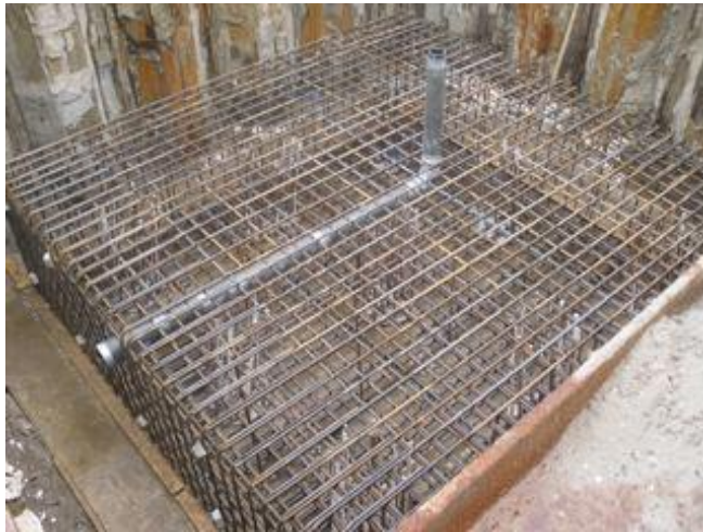
Figuur 166 - De complete poerwapening voor plaatsing van de wapening van de kruiskolom
