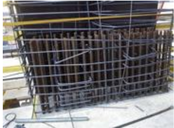
Figuur 71 - De eerste korf is geplaatst over de stekken van de rechthoekige kolom
