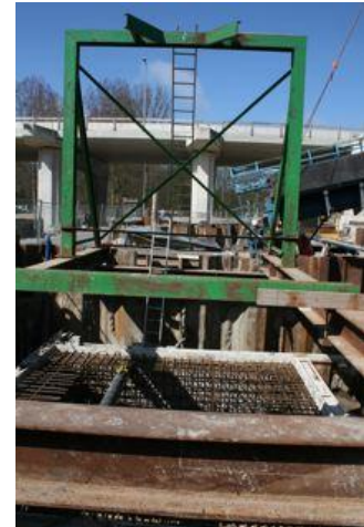
Figuur 169 - De poerkorf wapening zonder bovenwapening
