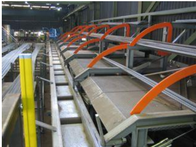
Figuur 33 - Door de goot gaan de staven naar het knipmes
