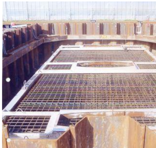
Figuur 102 - De stekwapening voor de kolommen ontbreekt
