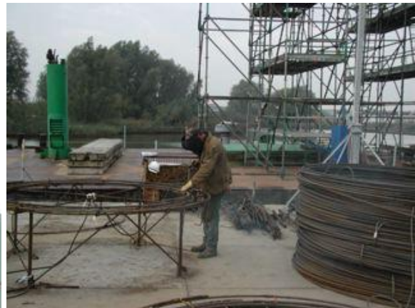
Figuur 176 - Het samenstellen van de kolom beugels
