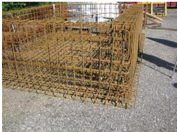
Figuur 50 - Prefab liftput
