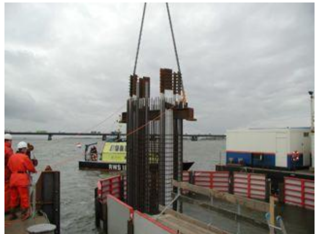
Figuur 180 - De paalkorf wordt in de onderwater staande tijdelijke bouwkuip neergelaten
