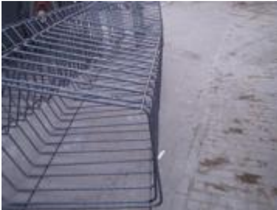
Figuur 70 - De prefabkorf uit de wapeningscentrale met vijfhoekige beugels
