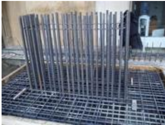
Figuur 67 - De funderingspoer met de stekwapening Ø 40
