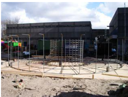
Figuur 81 - Begonnen wordt met enkele beugels op een vlonder van bekistingplaten
