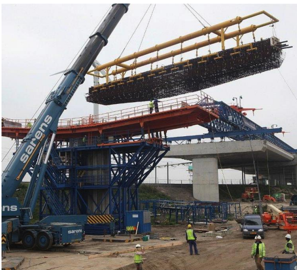
Figuur 160 - Het ophijzen van de geprefabriceerde pijlerbalkwapening uit de mal
