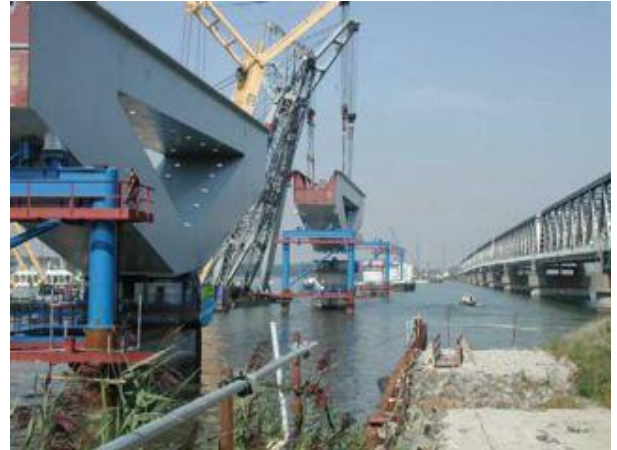
Figuur 185 - Het plaatsen van de 45 meter lange stalen prefab hamerstukken op de betonnen pijlers. Tijdelijk zijn hulpsteunpunten geplaatst voor het evenwicht van de hamerstukken.
