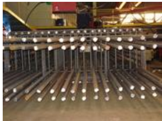
Figuur 65 - De 84 staven \varnothing 40 zijn er aan toegevoegd.
