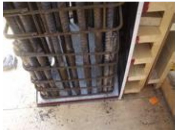
Figuur 73 - Door het gebruik van mechanische koppelingen blijft er voldoende stortruimte over.
