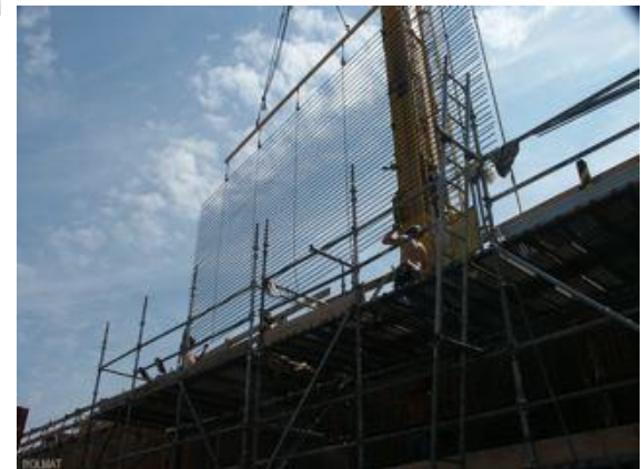
Figuur 94 - Rolmat hangt op zijn plaats op de nokken van de hulpstaven
