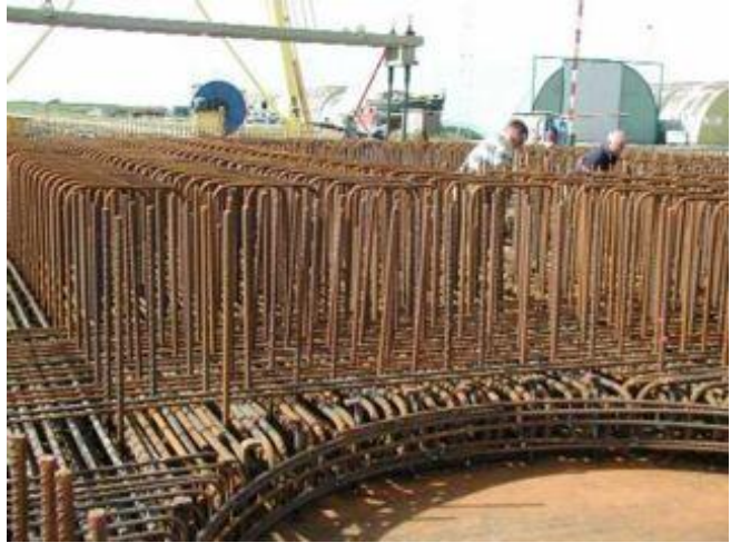
Figuur 173 - Het ondernet met dwarskrachtbeugels van de pijlervoet
