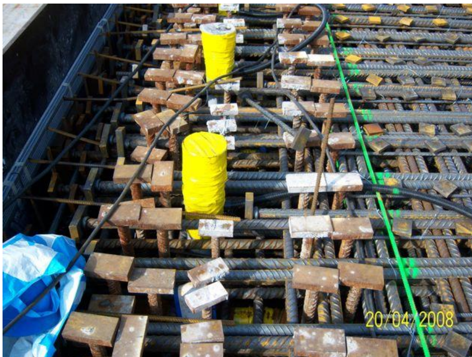
Figuur 188 - Ondanks alle inspanningen om meer te prefabriceren, zal er altijd wapening overblijven die ter plaatse moet worden gevlochten.
