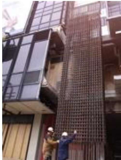
Figuur 68 - De 8.500 kg zware korf wordt over de stekwapening geplaatst
