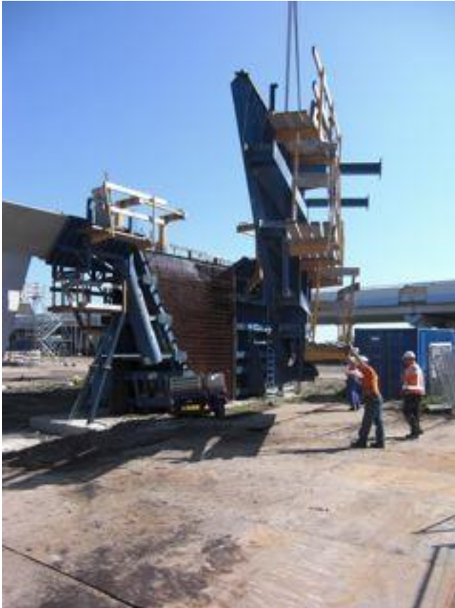
Figuur 136 - Het plaatsen van het sluitschot
