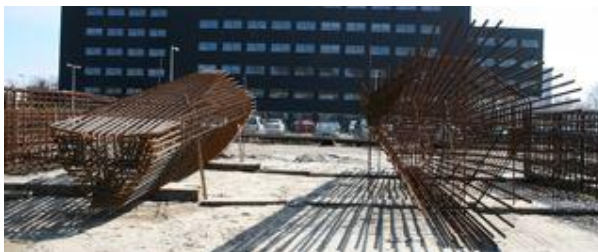
Figuur 168 - De taps toelopende achthoekige kolomkorven
