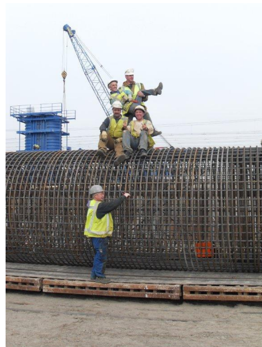
Figuur 148 – De korf is vervoerd naar de kolombekisting
