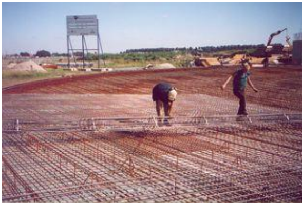
Figuur 100 - Net 11 wordt uitgerold. Totaal 930 kg ligt op zijn plaats zonder een staaf op te pakken!
