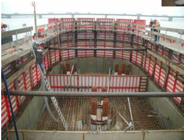
Figuur 182 - De wapening voor de pijlervoet en stekwapening voor de pijlerkolom
