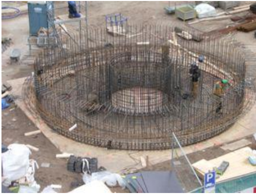
Figuur 82 - De vlechters kunnen er aan alle kanten bij om in alle rust de korf vorm te geven
