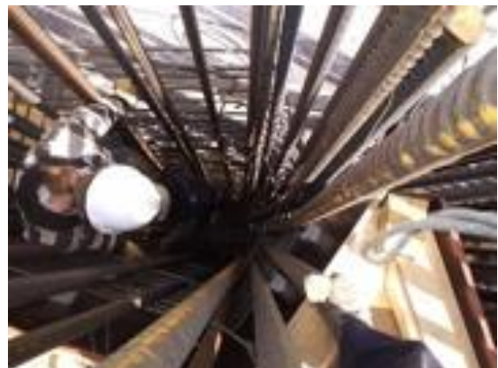
Figuur 75 - Om de staven verder met een momentsleutel te kunnen aandraaien, is de vlechter in de kolomwapening afgedaald
