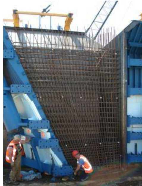
Figuur 135 - Het stelschot is om de prefab korf geplaatst
