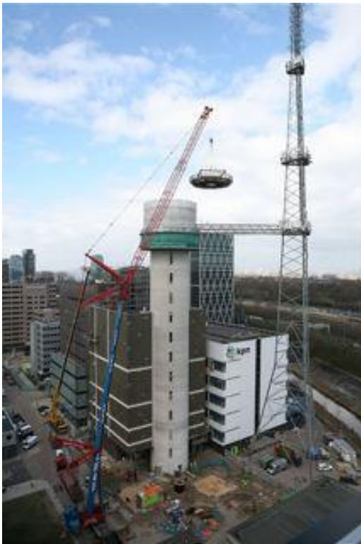
Figuur 84 - De korf wordt met een zware mobiele kraan met een verlengde jib giek naar 70 meter hoogte gehesen
