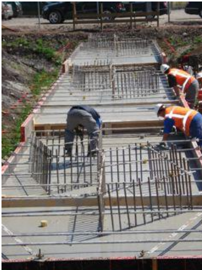
Figuur 132 - Direct na het storten wordt de betonspecie vlak afgewerkt. De stekken steken boven de beton uit.
