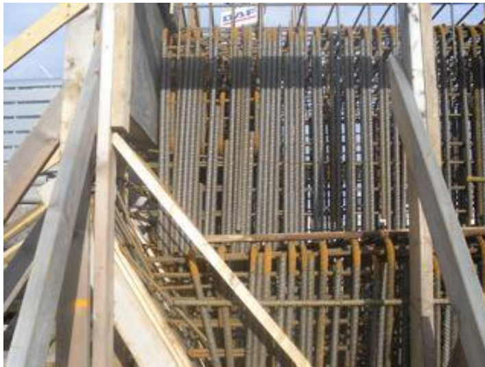
Figuur 155 - De proefopstelling: dezelfde plaats als van de vorige figuur maar nu aan het eind van de pijlerbalk nabij de spankoppelen van de voorspanning. Allemaal \varnothing 32 tegen elkaar.
