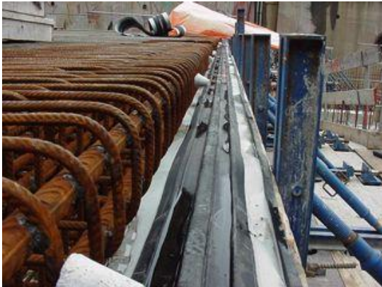
Figuur 139 - De eerste helft van het kopschot is geplaatst. Het is zodanig vormgegeven dat de voegslab vrij op zijn plaats kan worden gebracht.
