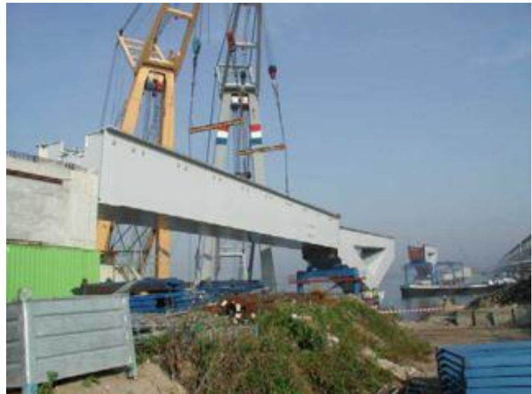
Figuur 186 - Het plaatsen van de 60 meter lange stalen prefab kokerliggers tussen de hamerstukken
