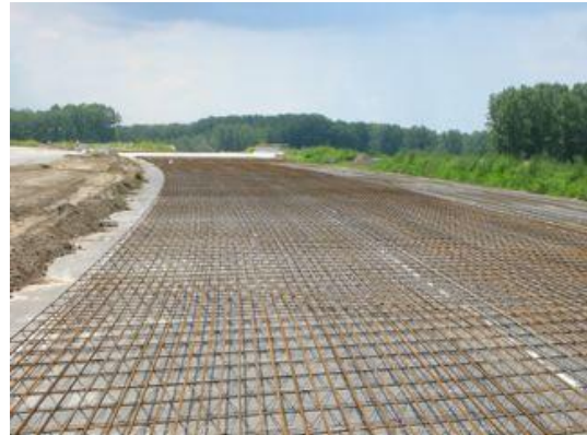
Figuur 131 - De rolmaten op lijnsuporten klaar voor slippaver met de betonspecie
