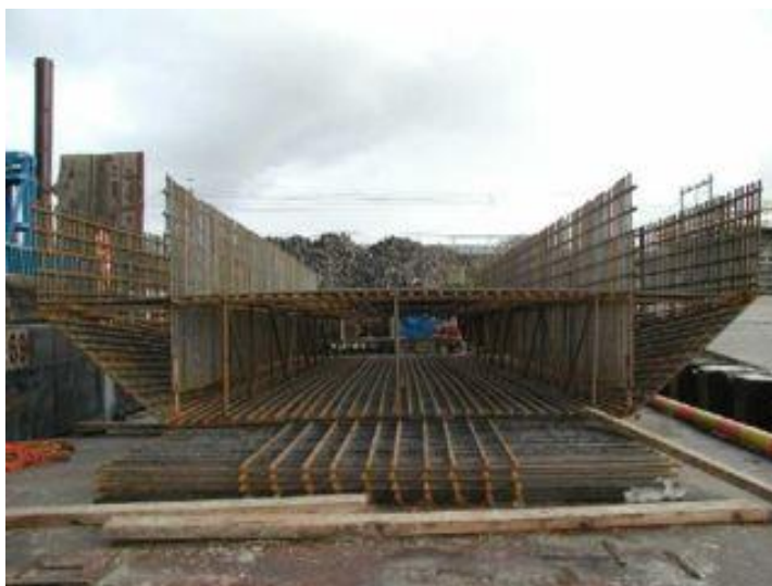
Figuur 183- De pijlerkolom wapening voor één pijler is op een dekschuit geladen om te worden vervoerd naar de bouwlocatie
