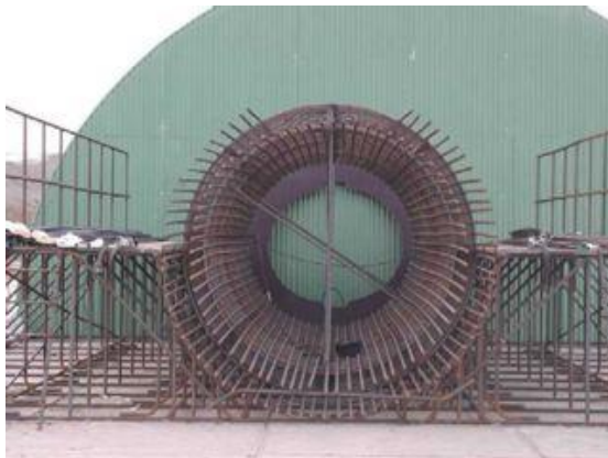
Figuur 177 - De mal met een wapeningskorf
