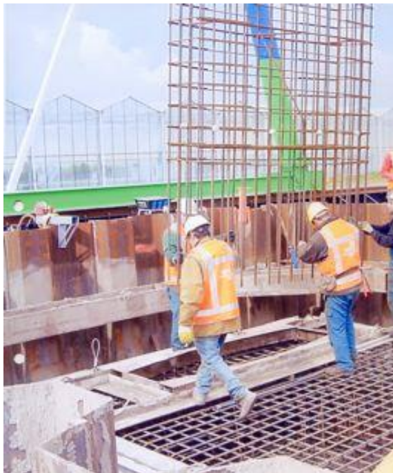
Figuur 103 - Voor het storten van de poeren eerst de kolomwapening plaatsen
