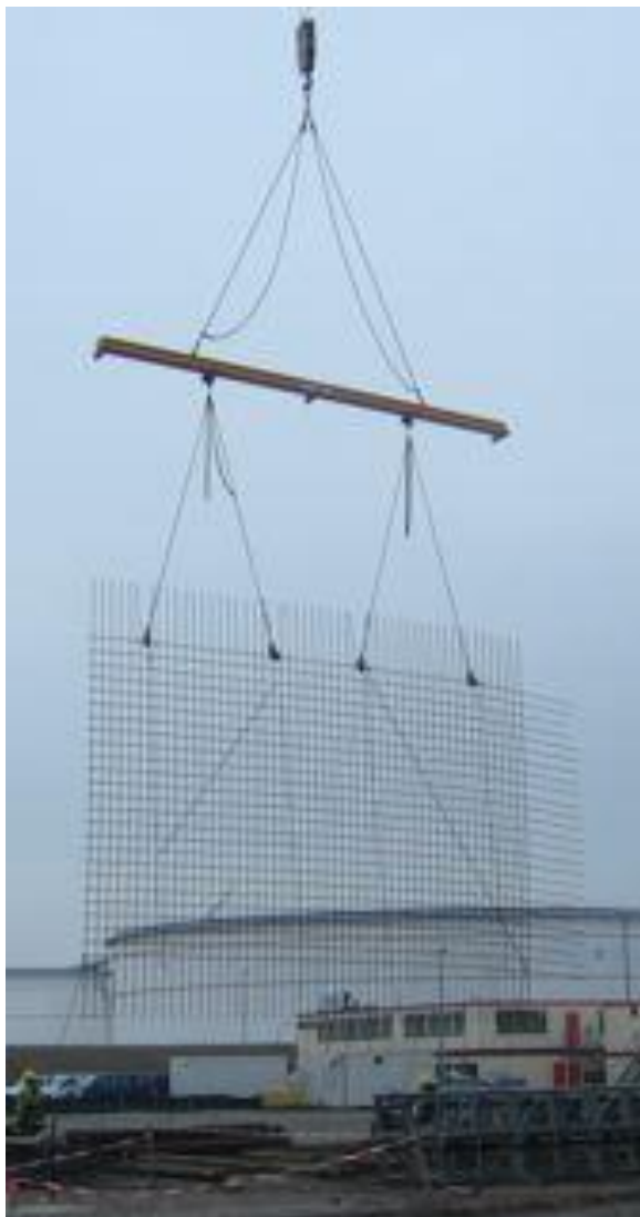
Figuur 18 - Een op de bouwplaats gemaakt prefab kruisnet van Ø25-200 # met een maximale afmeting van 16 x 8 meter(!!) voor de LNG tanks
