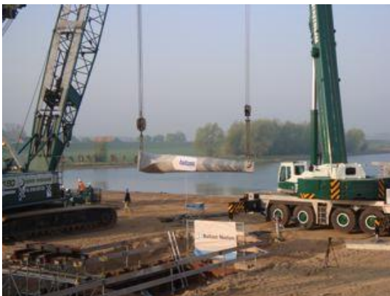
Figuur 121 - Met twee kranen oppakken
