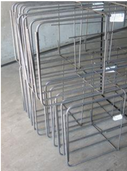
Figuur 40 - Prefab balken met dubbele haken
