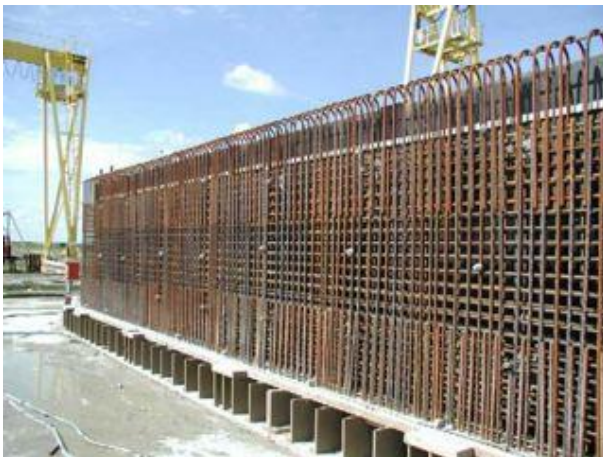
Figuur 174 - Het zijnet van de pijlervoet
