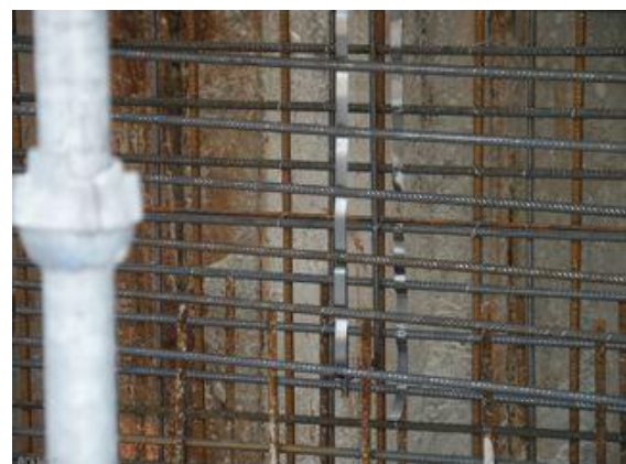
Figuur 95 - Wandwapening met rolmatten
