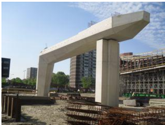
Figuur 171 - De pijlerbalk wapening met tot 15 meter lange staven wapening Ø 63 mm!
