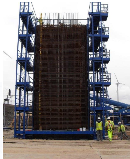
Figuur 151 - De korf zakt over de stekeinden
