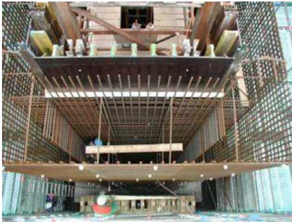
Figuur 184 - Bovenaanzicht prefab pijlerkolom wapening met binnenbekisting
