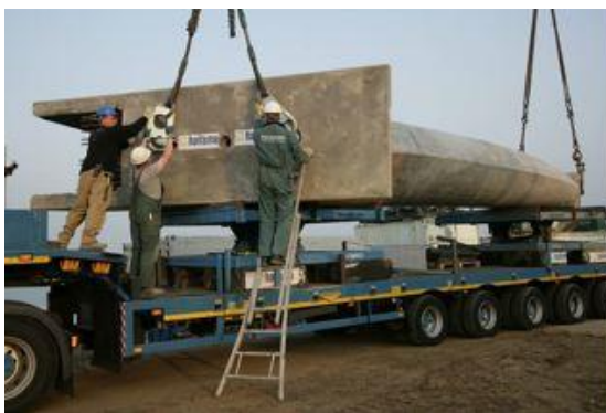
Figuur 120 - Pijler komt aan op het werk
