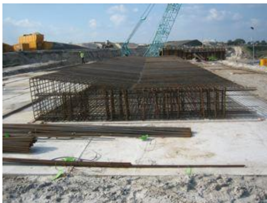
Figuur 126 - De korf wordt buiten het werk gemaakt op een vlinder met vaste maatvoering voor de volgende korven
