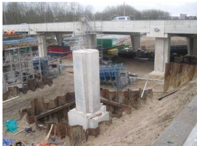
Figuur 167 - De kruiskolom is gestort. De damwandkuip kan worden getrokken
