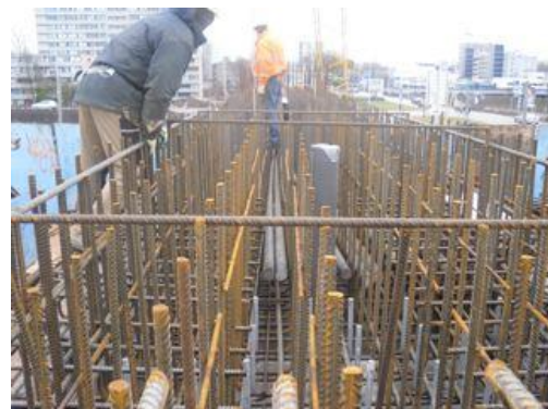
Figuur 171 - De pijlerbalk wapening met tot 15 meter lange staven wapening Ø 63 mm!
