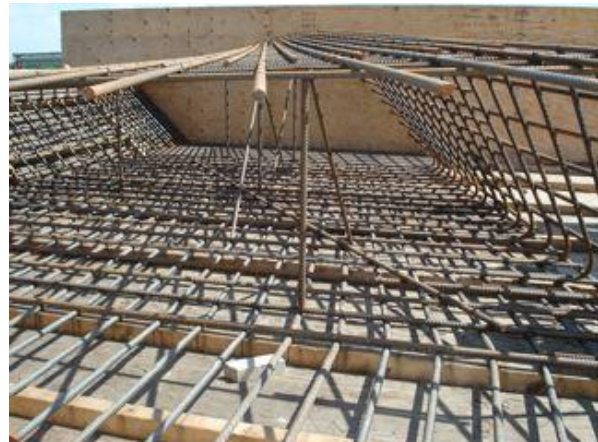
Figuur 133 - De prefab pijlerkorf ligt klaar om in het werk te worden gehesen
