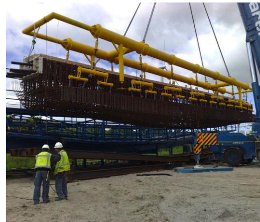
Figuur 161 - Na het transporteren van de 27.50 meter lange en 3.50 meter brede pijlerbalkkorf naar de pijlerkolom waar de bodemplaatbekisting onder de juiste verkanting klaar ligt, kan de korf geplaatst worden. De 160 ton zware prefab kokerliggers voor het dek worden met een traverse wagen geplaatst
