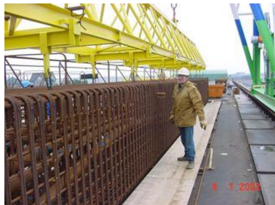
Figuur 111 - Voor het aanpakken is een lange evenaar met vele aanpikpunten ontwikkeld
