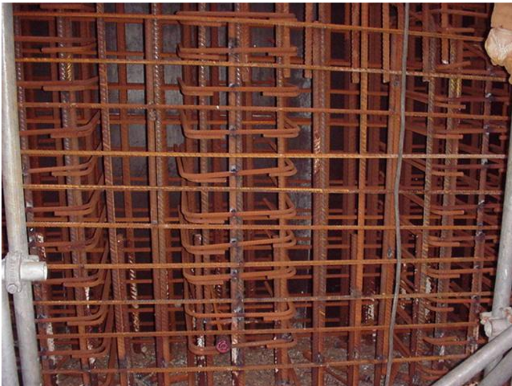
Figuur 48 - Twee korven met dwarskracht haarspelden in elkaar
