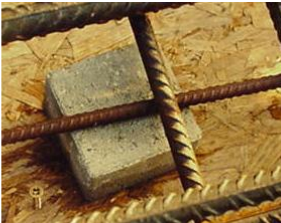
Figuur 8 - Borgstaaf op stelblokjes
