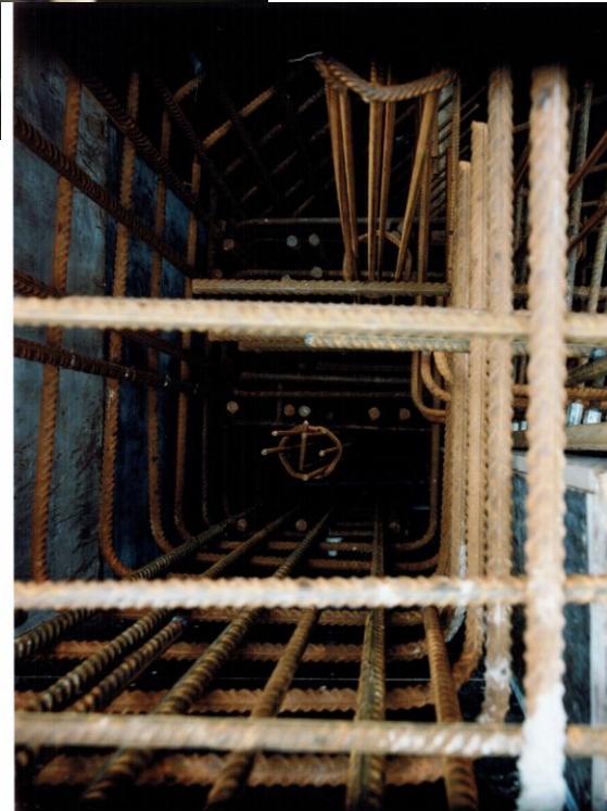
Figuur 59 - Stortkokers (wapeningsstaal) tussen de wapening
