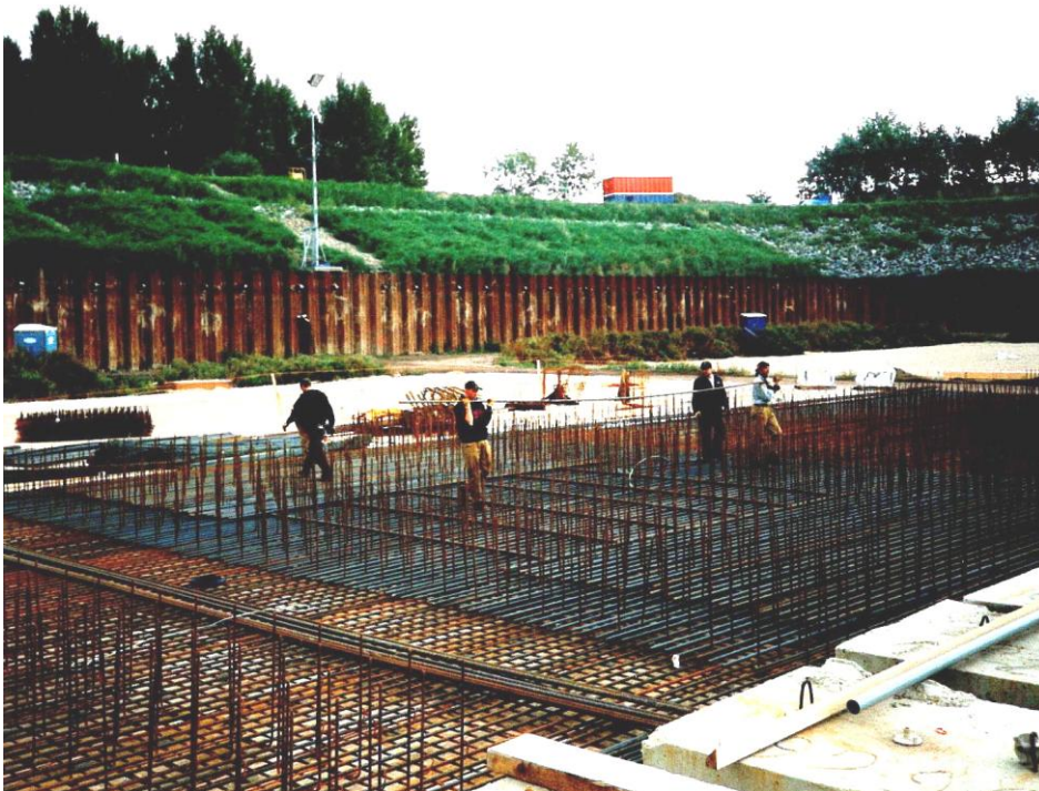
Figuur 33 - Vlechters tillen tot schouderhoogte de zware staven hoofdwapening op
