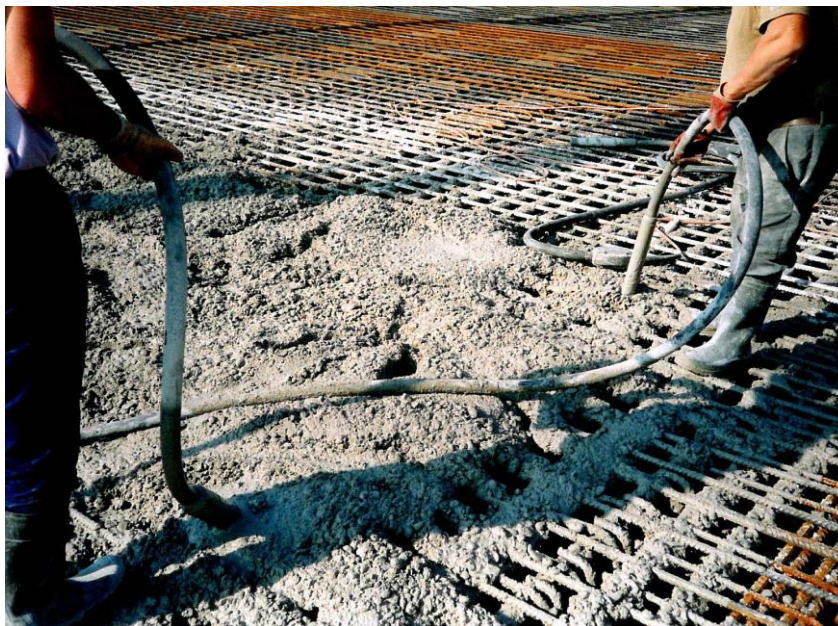
Figuur 55 - Op vele plaatsten kan de trilnaal niet door het dichte wapeningsnet
