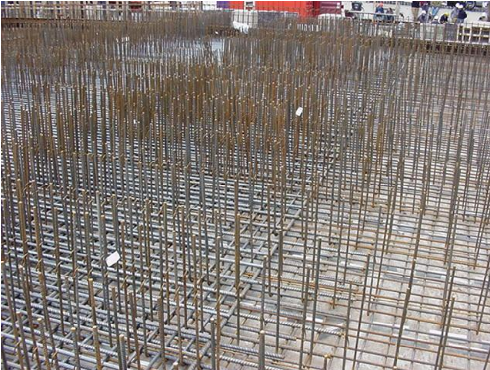
Figuur 1 - Een vloer van een tunnelmoot met (nog maar) de helft van de dwarskrachtwapening
