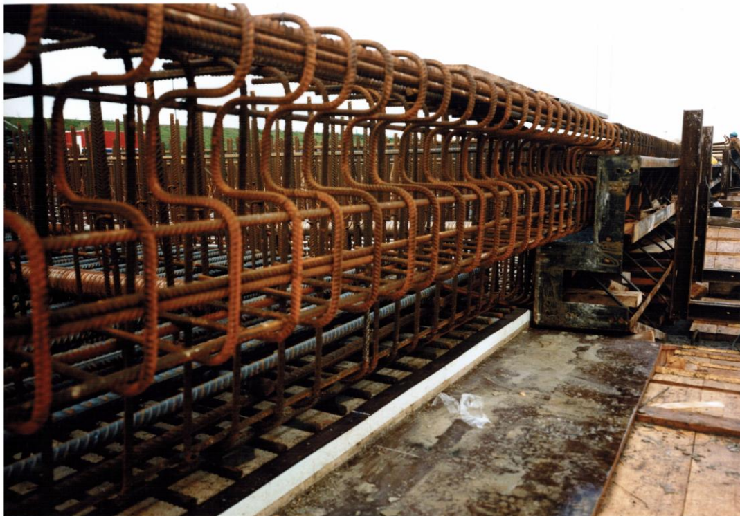
Figuur 69 - Slingerbeugel in mootvoeg dek tweede Beneluxtunnel
