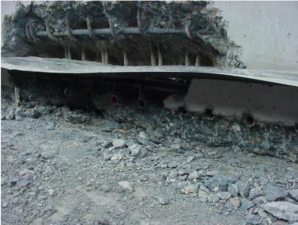
Figuur 64 - Het resultaat als de trilnaald er niet bij kan
