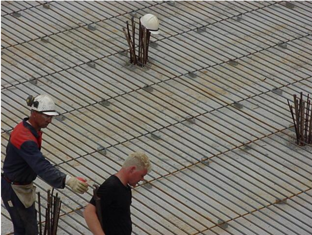
Figuur 71 - Eerste laag wapening op borgstaven en stelblokken
