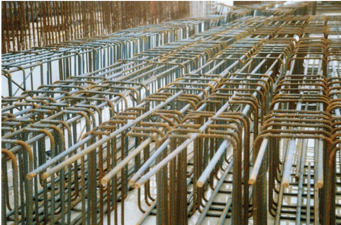
Figuur 41 - Prefab korven liggen klaar om in het werk te worden gehesen. Veel arbeid blijft hiermee buiten de cyclus.
