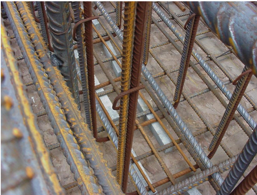
Figuur 16 - Extra (in hoogte verspringende) beugeltjes om de overlappingslas goed te laten aansluiten
