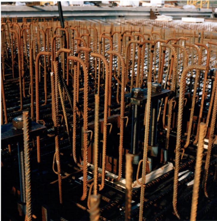
Figuur 14 - Geen verspringende haarspelden. Dit veld is wel goed toegankelijk voor vlechters.
