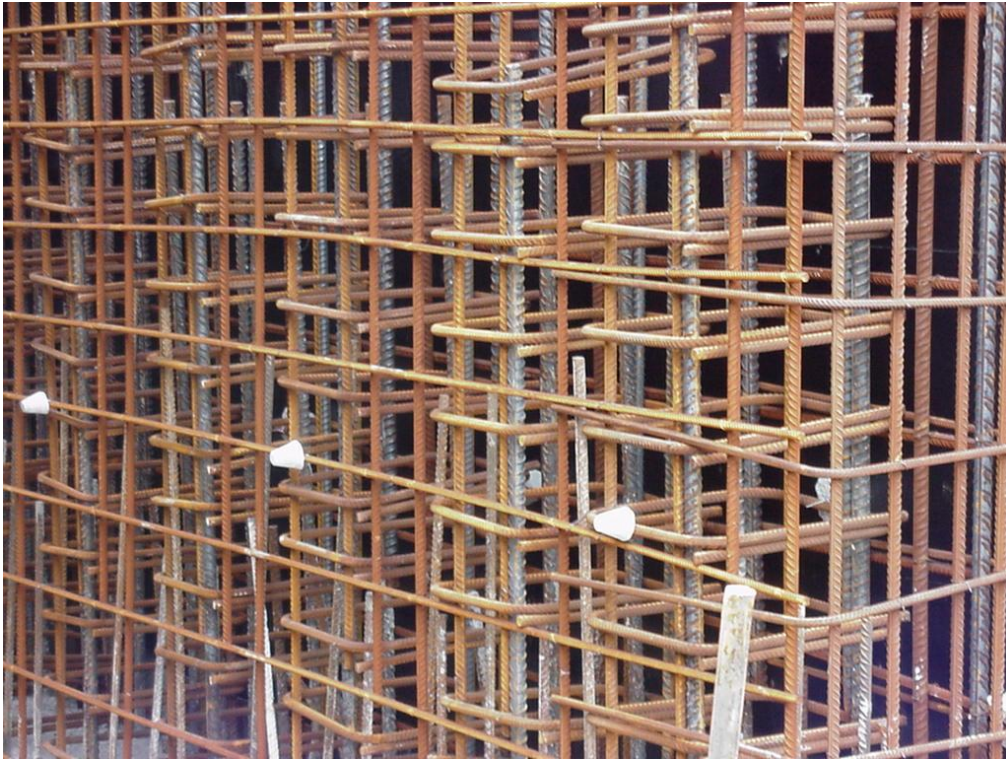
Figuur 47 - Korven aangevuld met losse verticale en horizontale staven.
