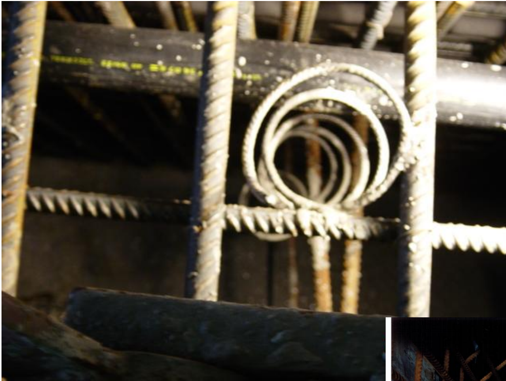
Figuur 58 - Een wapeningsspiraal om de specie met normale trilnaalden te verdichten
