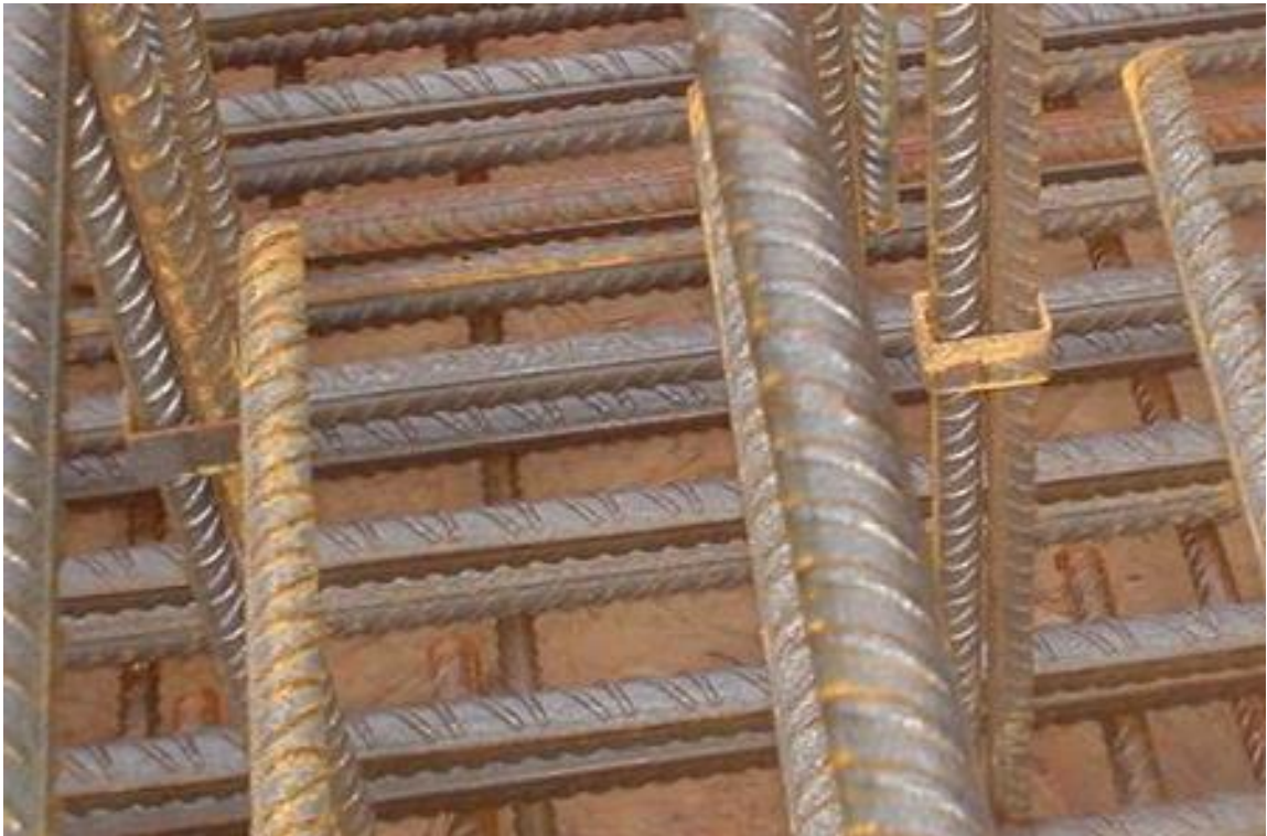
Figuur 37 - De twee benen van de haarspelden liggen strak langs elkaar. Goede overbrenging van de dwarskracht is hiermee geborgd
