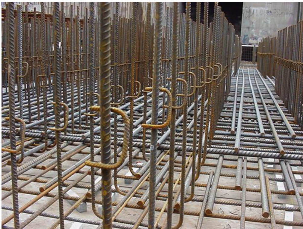
Figuur 73 - De laag verdeelwapening is aangevuld met enkele staven Ø 40 mm
