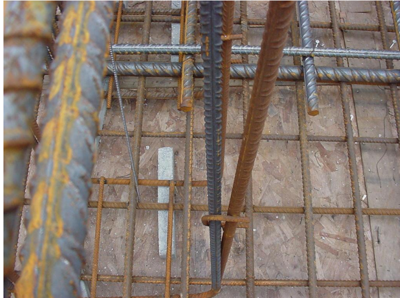
Figuur 35 - Zo hoort het niet. Boven- en onderhaarspeld hebben met elkaar geen laslengte. Dit kan gebeuren wanneer de kleine beugeltjes op gelijke hoogte aan de twee eind van de haarspeld zijn gelast.
