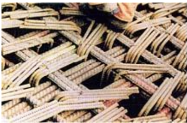
Figuur 49 - Chaos, niet te verdichten.
