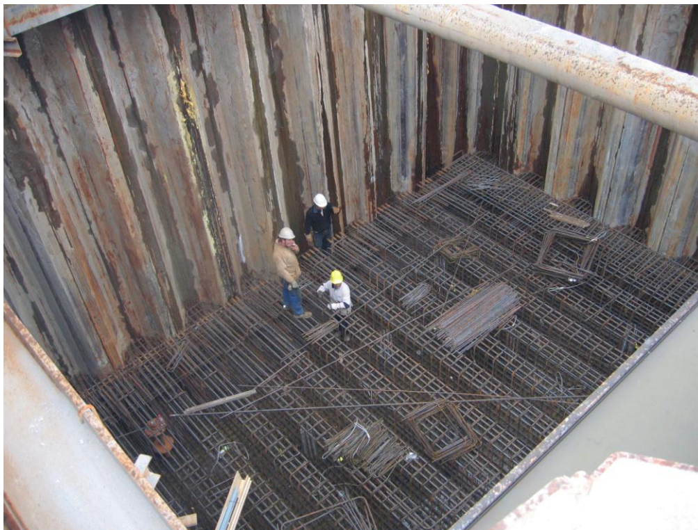
Figuur 43 - Prefab korven in een diepe bouwput. De vlechters halen hier hoge productiesnelheden.
