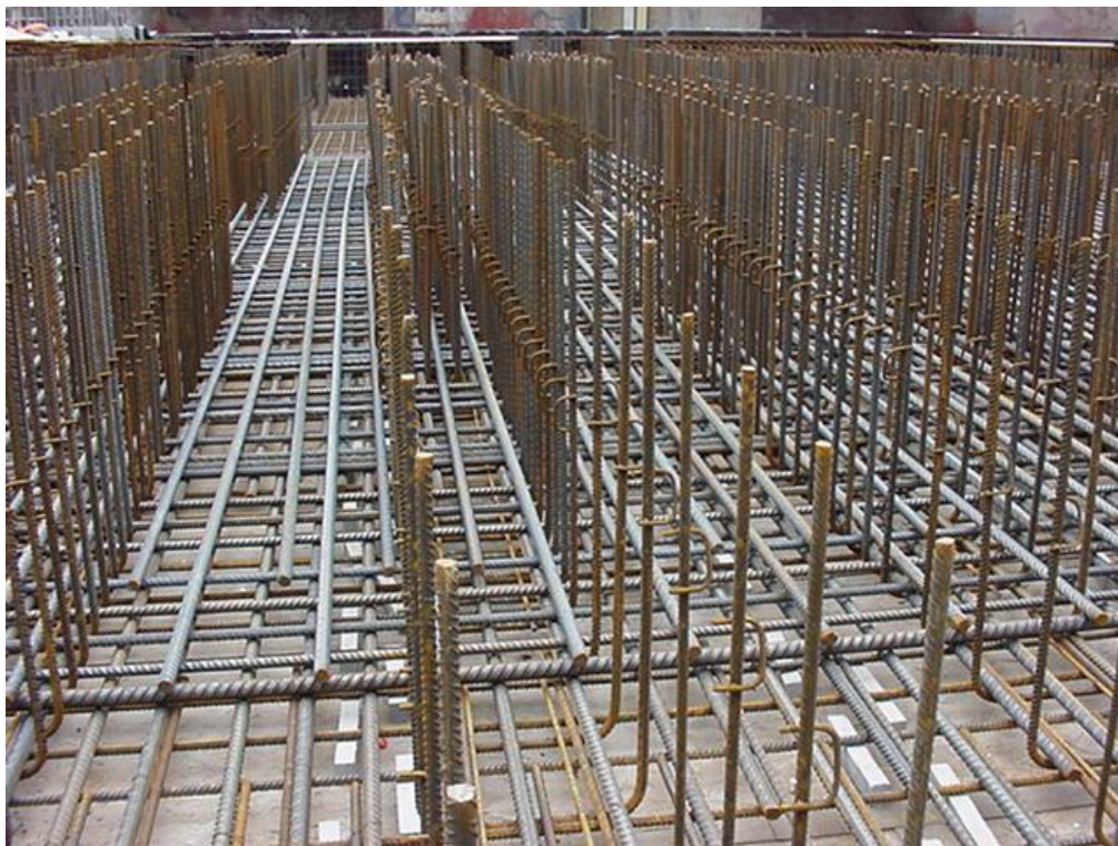
Figuur 70 - Uitvoering op stelribben. De onderlinge afstand tussen de dubbele rij is te klein.
