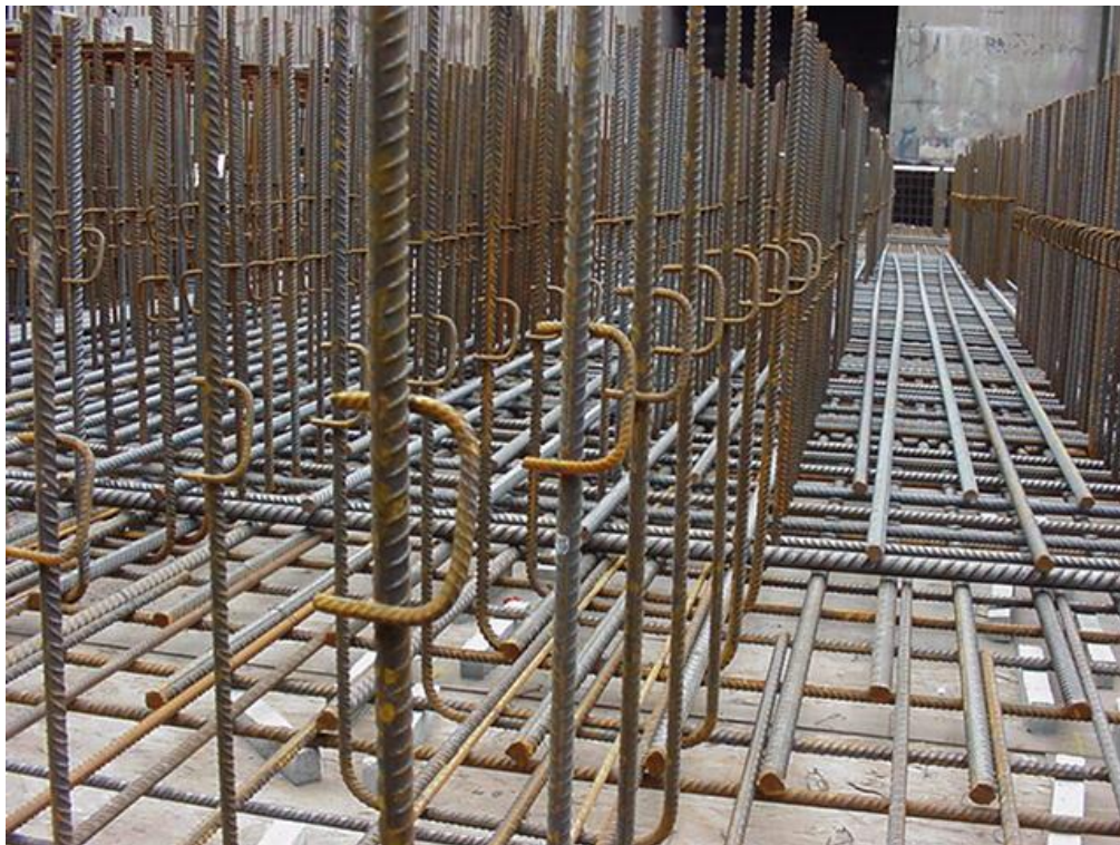
Figuur 39 - Zwaardere dwarskrachtwapening leidt tot lagere wapeningskosten en een betere uitvoerbaarheid voor de vlechters
