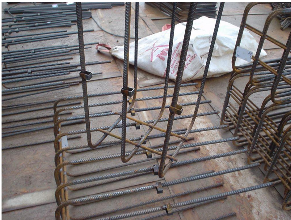
Figuur 36 - Met een enkele las is een kokertje aan de haarspeld gelast
