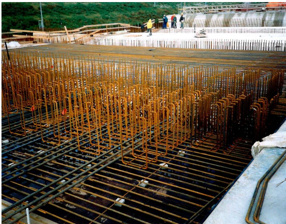
Figuur 32 - De eerste helft van de hoofdwapening en de prefab korven zijn geplaatst
