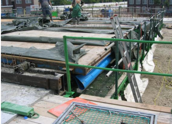
Afdekkappen worden opgelegd op de randen van de kimbekisting
