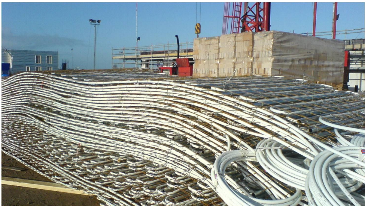
Opslag van prefab leidingregisters op de bouwplaats
