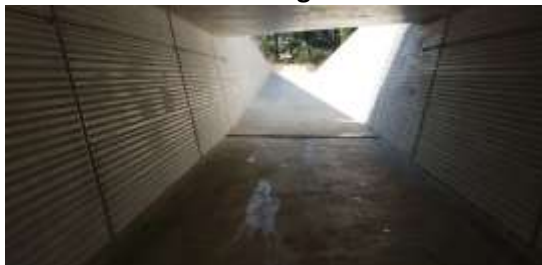
Lijnspeel betonnen vloer, prefab wanden
