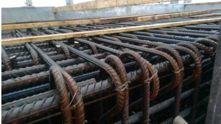
Grote wapeningsdichtheid heeft invloed op betonsamenstelling en wijze van storten en verdichten
