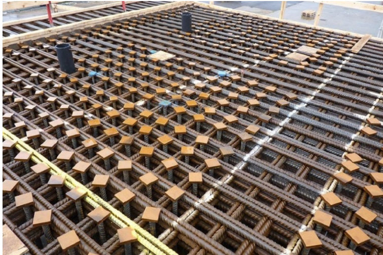
Toepassing van kopdeuvelstaven (T-heads) tussen de hoofdwapening
