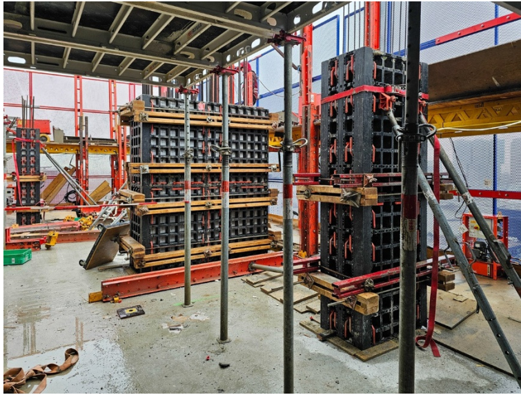
Figuur 9 Kolommen en penanten zijn uitgevoerd met een kunststof bekisting
