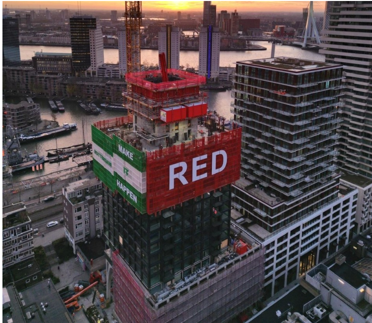
Figuur 10 Met veiligheidsscherm ontstaat een cleane bouwmethode. Onder het scherm komende de verdiepingen er wind- en waterdicht vandaan
