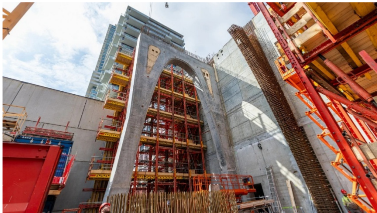
Figuur 15 Bogen in uitvoering
