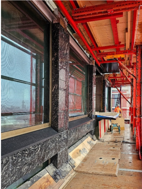
Figuur 11 Gevels aangebracht binnen het veiligheidsscherm
