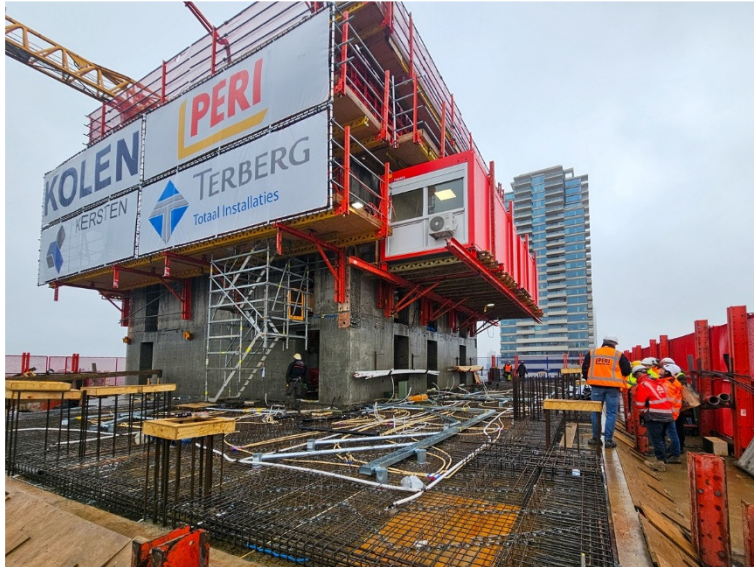
Figuur 7 Kernbekisting met geïntegreerde bouwketen
