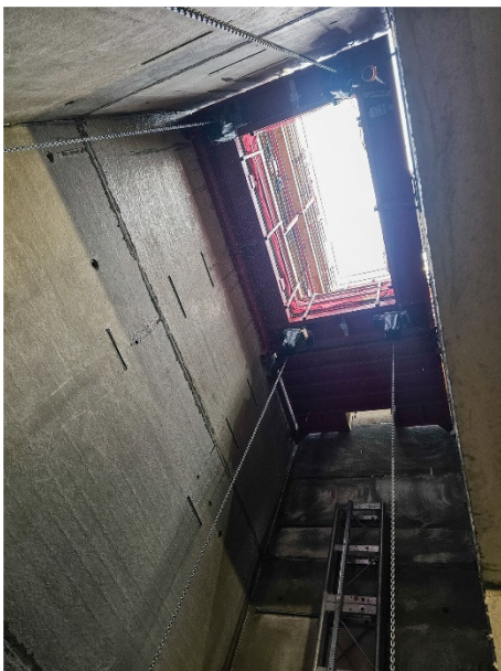
Figuur 12 Vlondersysteem in de liftschachten
