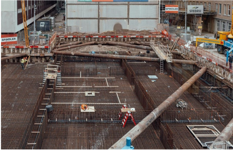
Figuur 16 Wapening in de funderingsplaat
