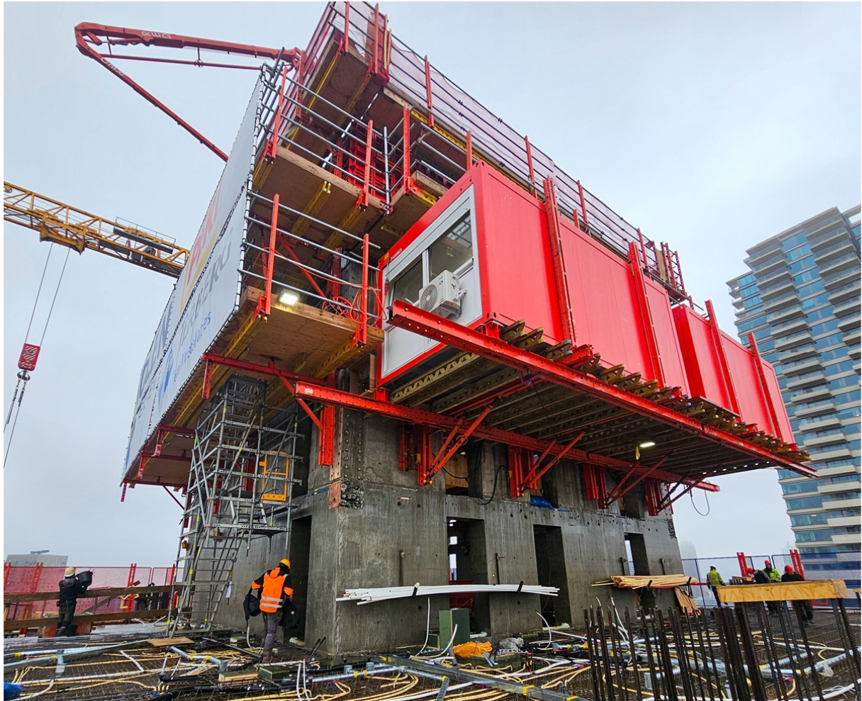
Figuur 1 Hydraulisch klimmende kernbekisting
