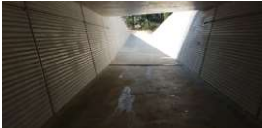
Lijnenspel betonnen vloer, prefab wanden
