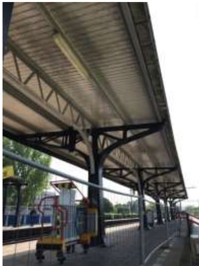
Nog te renoveren overkapping wordt na renovatie teruggeplaatst
